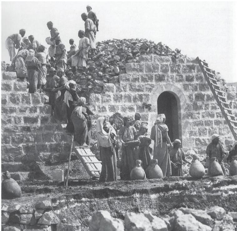
**Fig. 35** : Chantier de construction d'un toit en dôme en pierre dans un village Palestinien à L'époque du mandat britannique. Nous remarquons la présence des femmes sur le chantier. Matson Collection, Library of Congress (Amiry et al, 1989).
