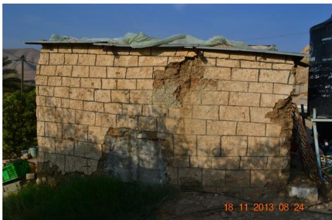
**Fig. 135** : Façade est de la maison Jiftlik 2, au niveau des sanitaires. Les murs en adobe ont été affaiblis par une mauvaise intégration des conduits d'eau.
