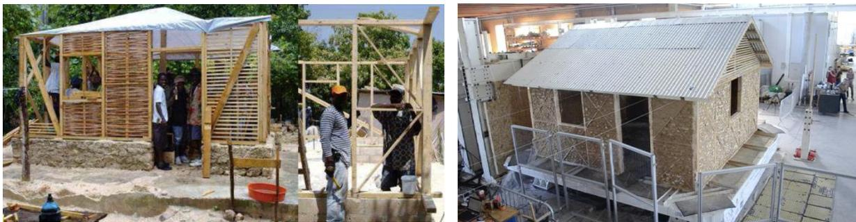
**Fig. 23 et 24** : Prototypes proposés par le CRATerre pour la reconstruction d'Haïti. Deux typologies sont développées. Les murs à ossature bois sont remplis soit en pierre (à droite) soit en terre crue (à gauche). (Garnier et al, 2014).
