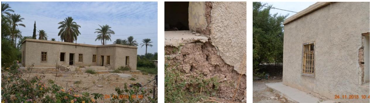
**Fig. 96, 97 et 98 :** La maison Jéricho 13. Construite en adobe, elle se caractérise par l'usage du béton et du ciment dans ses systèmes constructifs : toiture, fondation et enduit (Photo : Rania Daher, 2013).
