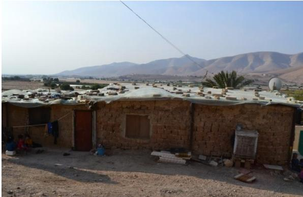
**Fig.131** : Façade nord de la maison Jiftlik 2 sans enduit, les briques d'adobe sont apparentes. Nous remarquons aussi la fragilité de la toiture. (Photo : Rania Daher, 2013)
