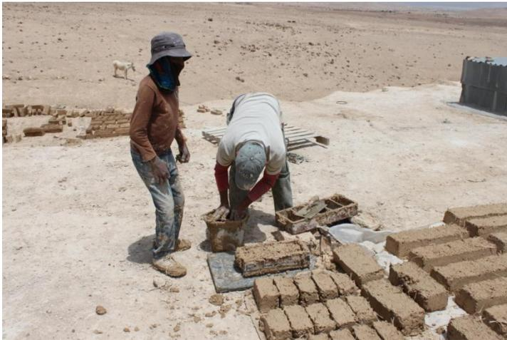
**Fig. 136** : Production des briques d'adobe par le programme du MA'AN Development Center.
