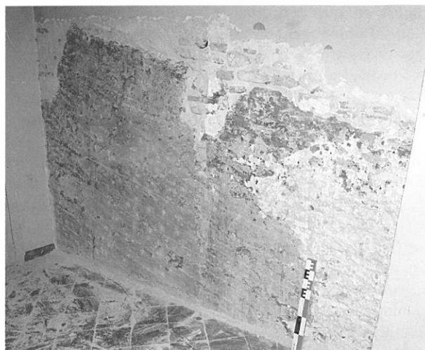
Fig. 21 : Partie supérieure d'un mur latéral, réalisée en bauge coffrée. Noter l'absence de limite d'assise ou de banche, de trou de clé et la précision du moulage des planches obliques du coffrage.
