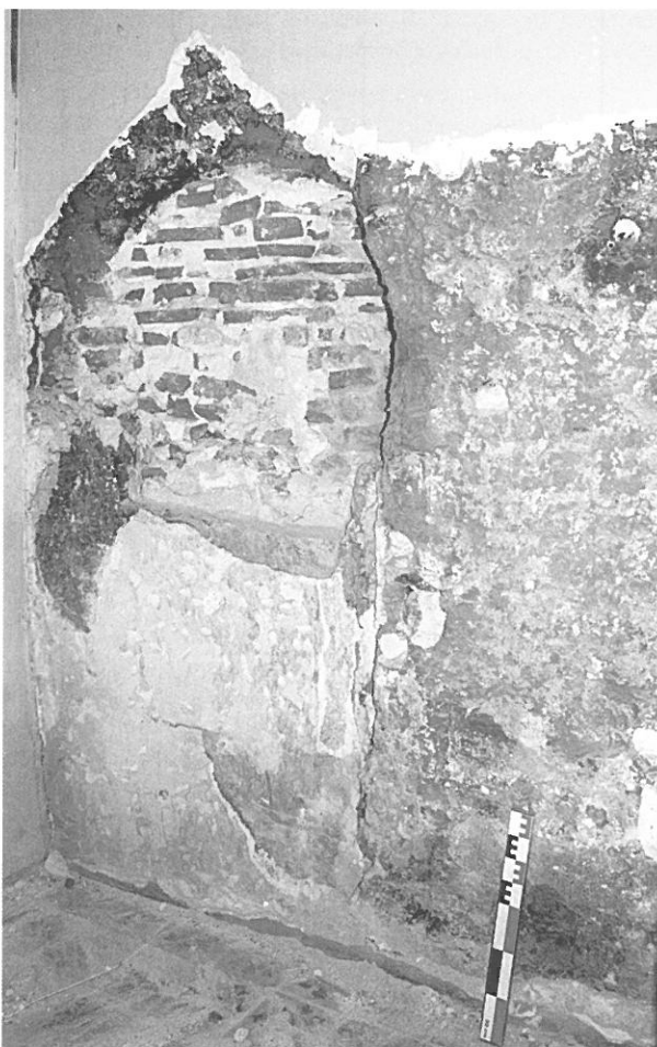
Fig. 34 : Le percement de la porte indique le rassemblement de cette parcelle avec la voisine et son bouchage correspond à un retour au parcellaire initial.
