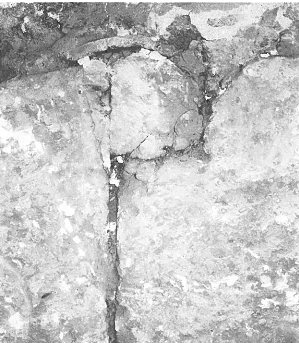
Fig. 12 : Limite verticale d'une banchée dans un mur de pisé. Le trou de clé, couvert par un fragment de tuile, est bouché avec de la terre.
