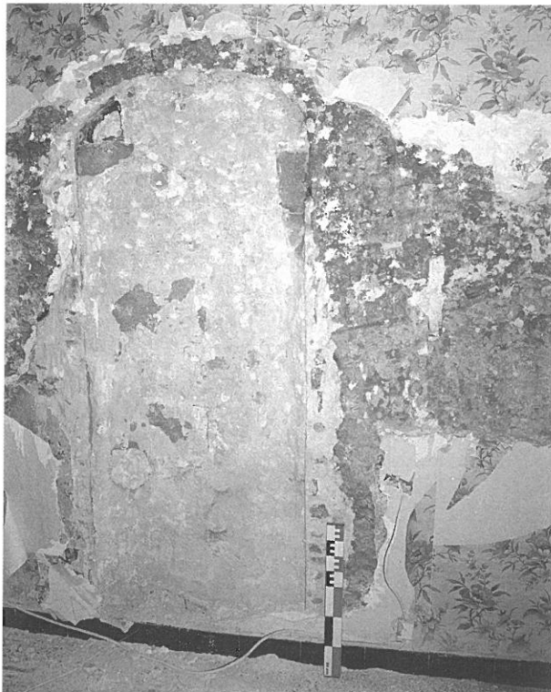
Fig. 40 : Le percement de la porte témoigne du rassemblement de cette parcelle avec la voisine et son bouchage correspond à un retour au parcellaire initial.
