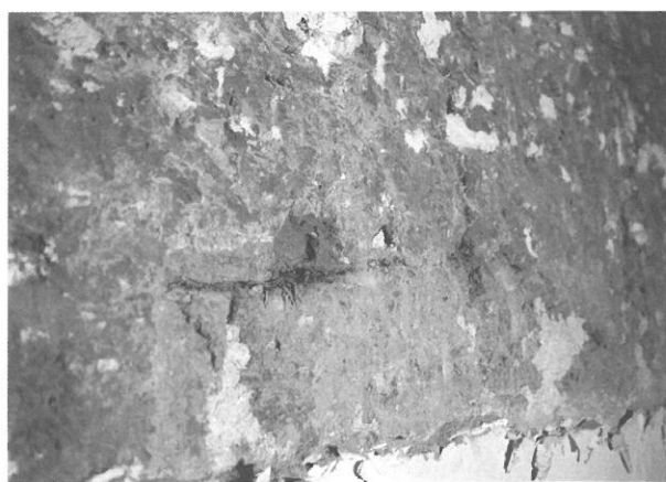
Fig. 17 : Lit de végétaux entre deux assises d'un mur de pisé au 33bis rue Arago.
