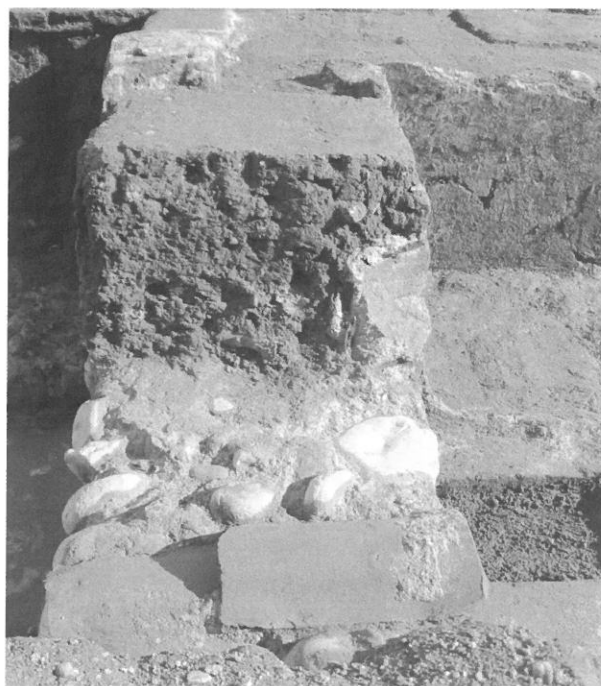
Fig. 22 : Mur de pisé sur soubassement et fondation en pierre découvert au couvent des Franciscains (Perpignan). L'arase supérieure du solin est traversée par un trou de clé recouvert par des tuiles (H. Gazzal, avec l'autorisation de A. Bergeret).
