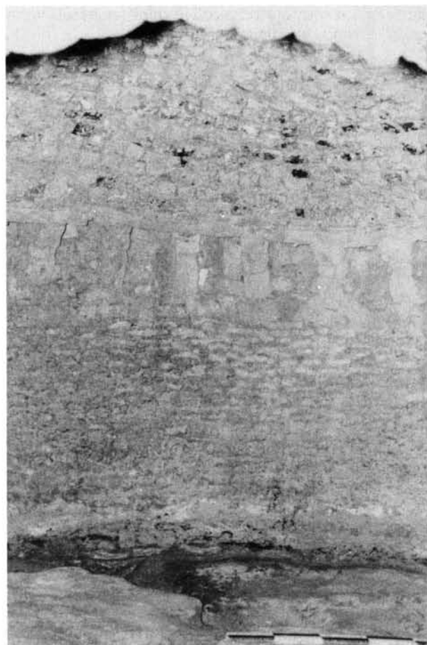
Fig. 8 : Paroi et voûte du foyer
