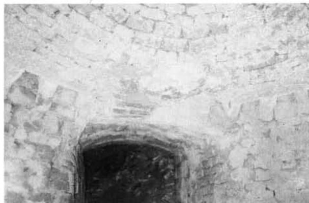
Fig. 17 : Vue intérieure au foyer vers la porte
