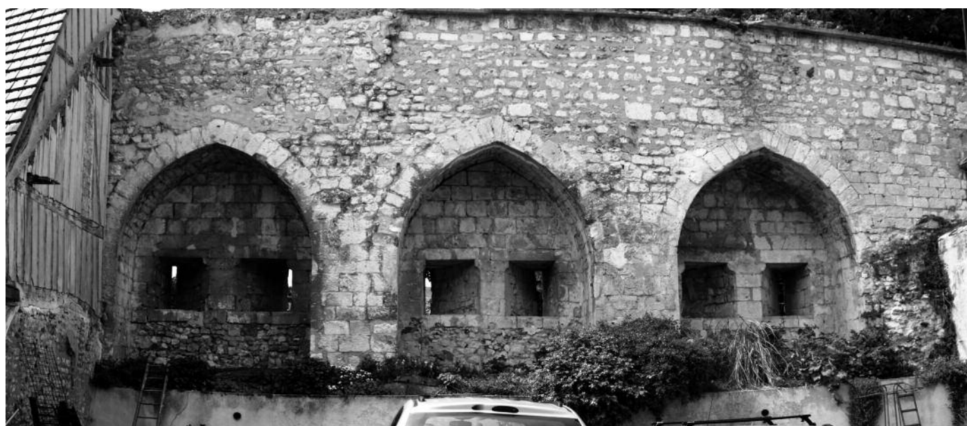
Fig. 26 - Vernon, enceinte urbaine, vue intérieure le long de la rue Potard, au nord-est.
