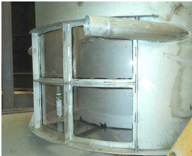
Figure 32 : vue d'ensemble des hublots du canal circulaire.
