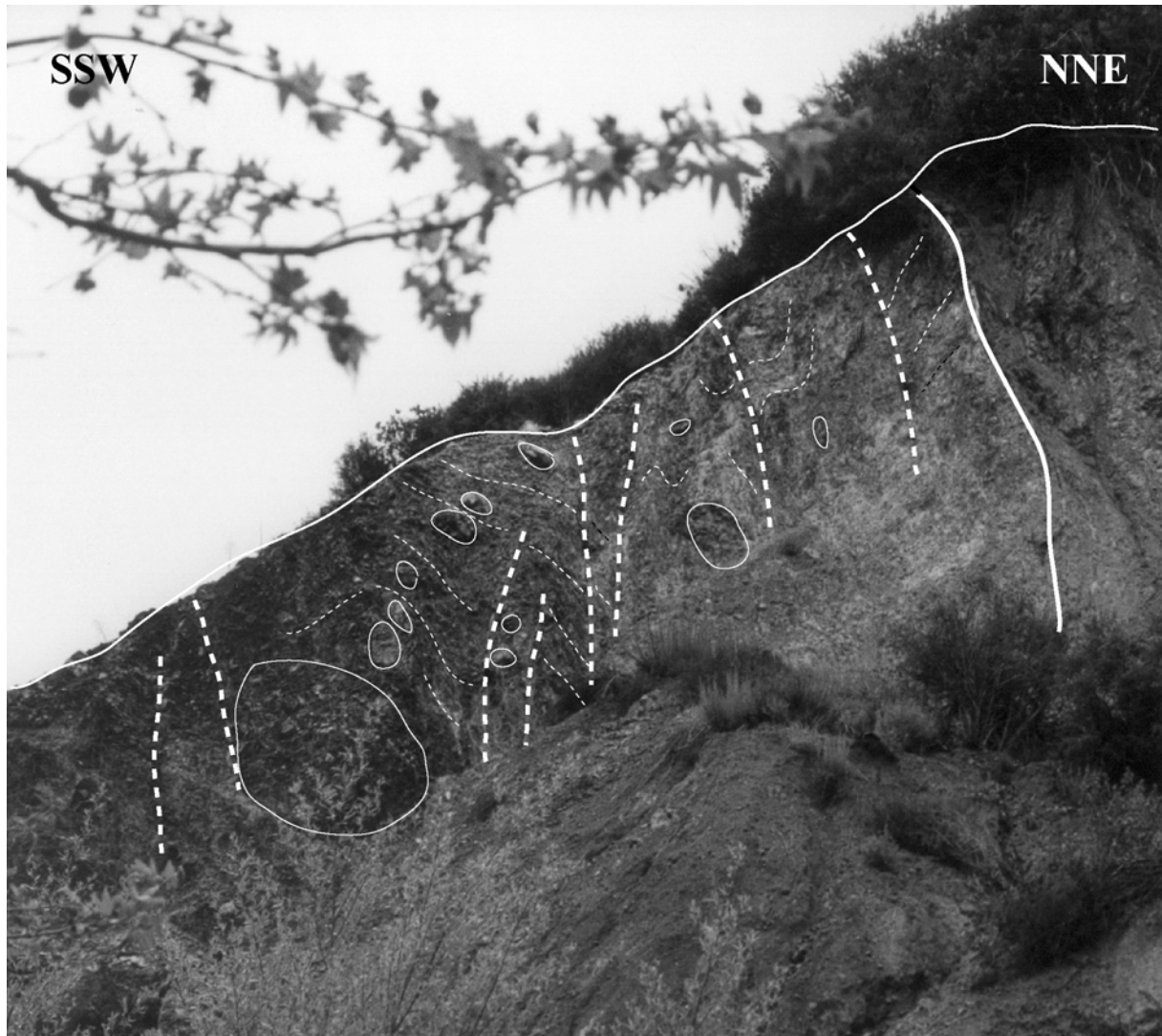
Fig. II.1-11 : Vue vers l'ouest du contact (trait continu épais) entre la lentille de serpentinites au sud et les sédiments éocène au nord. Les cercles blancs entourent des blocs massifs de serpentinites emballés dans une serpentinite schisteuse. Deux schistosités ont été identifiées : les pointillés fins soulignent la première, à pendage faible, et les pointillés épais marquent la seconde, à pendage plus fort, parallèle à l'orientation de la faille de Santa Ynez.
