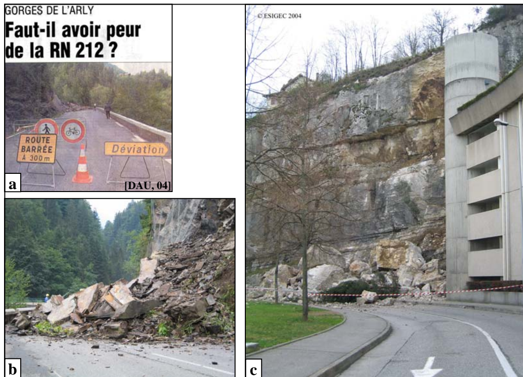
figure I.2 : (a, b) éboulement de 200 m 3 sur la RN 212 en juillet 2004 – (c) éboulement près du parking de la Falaise à Chambéry au printemps 2004
