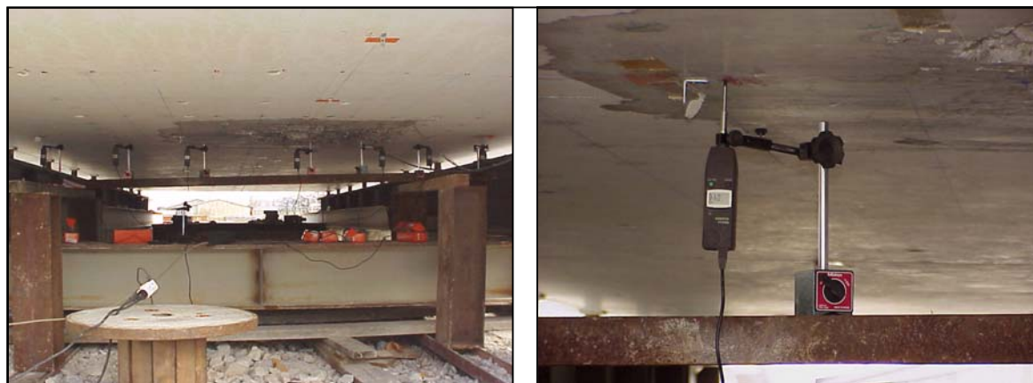
figure III.16 : dispositif de fixation des capteurs de déplacement pour un essai statique
