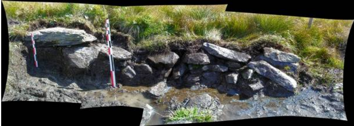
Figure 2.13 Photo du Muret présent à l'exutoire du lac du Thyl.
