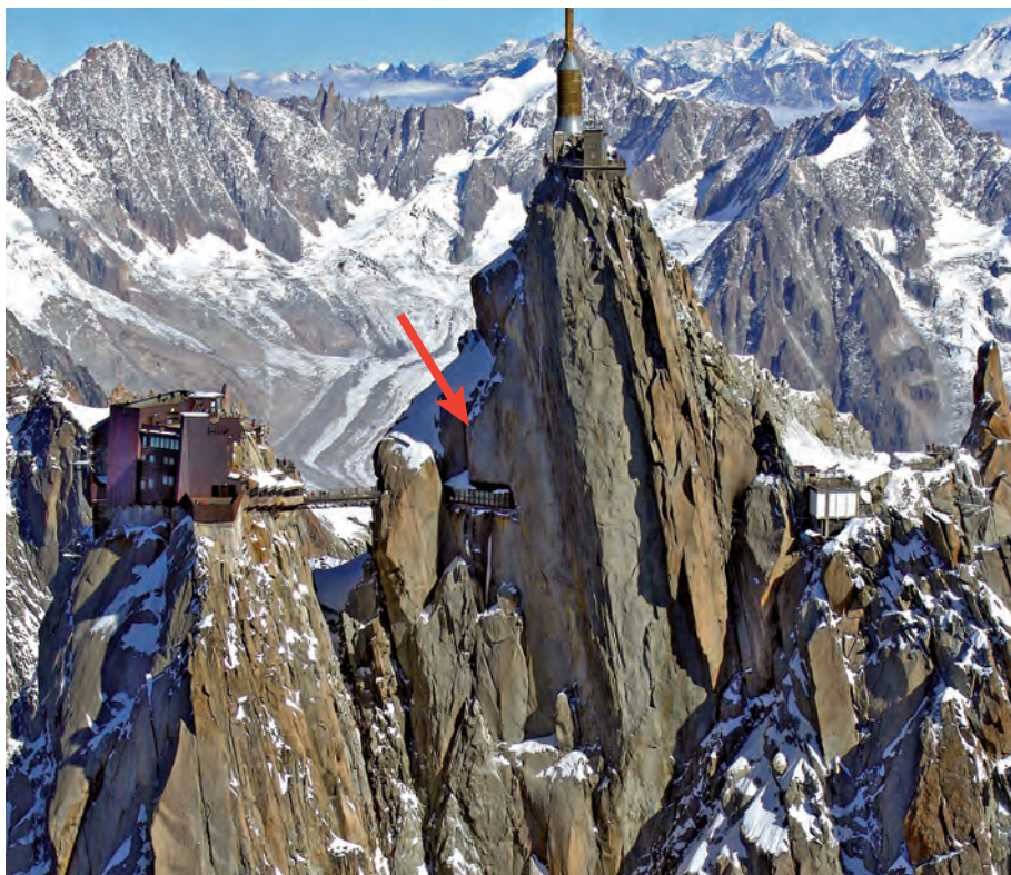
Figure 13 - Durant la canicule de l'été 2003, des écoulements d'eau dans des fractures habituellement sèches (remplies de glace ?) ont été observés dans les galeries de l'Aiguille du Midi (flèche). Des observations similaires ont été faites dans les galeries de la station sommitale du Jungfrauoch (Oberland bernois, 3500 m), avec des arrivées d'eau plus rapides et précoces chaque année qui indiquent un dégel progressif.
