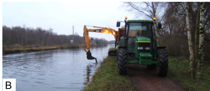
Figure II-1 : (A) Carte de la zone de curage. (B) Opération de curage
