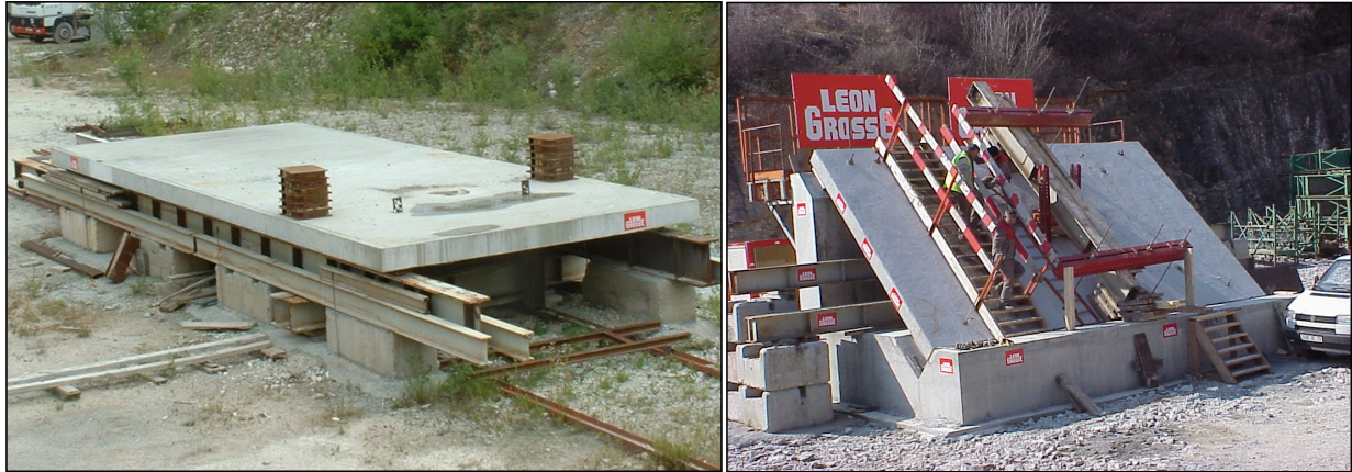
Figure III.2 : vue générale des dalles d'essai
