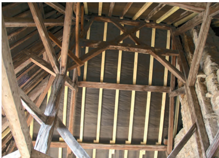
Figure 10 - Eléments dendrochronologiques de la charpente de la maison Currat à Conliège (Jura) qui a livré cinq bois. Les cinq séries synchronisées ont permis de construire une chronologie moyenne de 100 cernes. Notons la personnalité marquée des séries les plus courtes.
