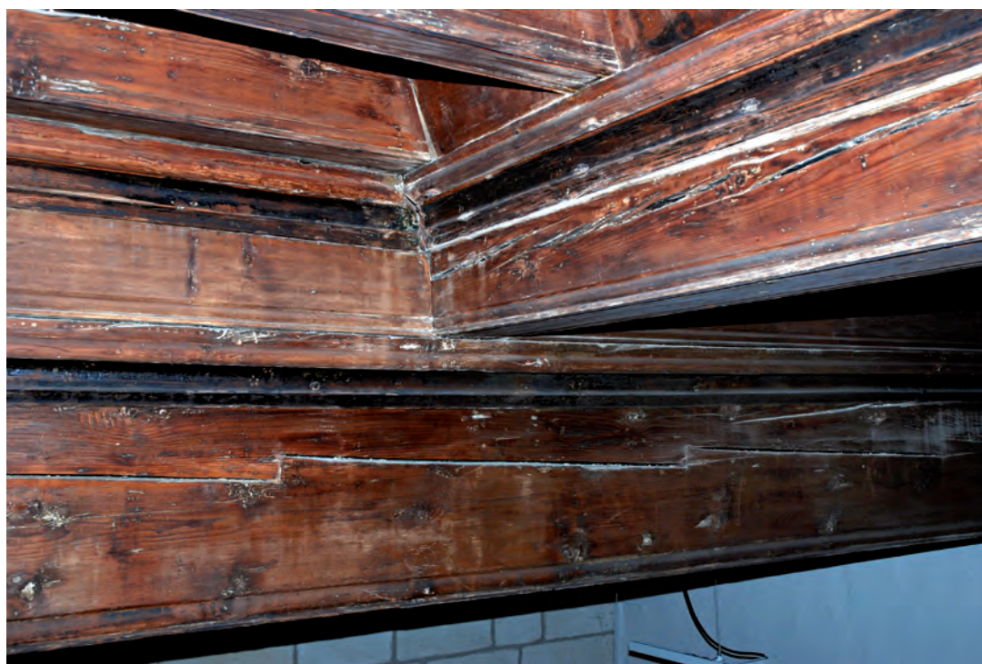
Figure 2 - Exemple d'une poutre armée du Petit-Palais, Avignon.
