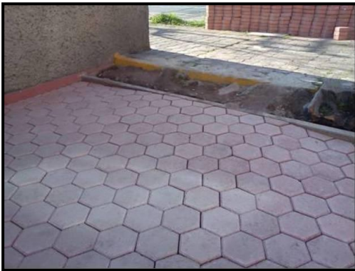
Foto 15. Adoquín colocado en una vía de circulación peatonal central. Residencial Las Arboledas, Lourdes, Colón.
