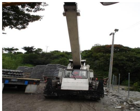
Grúa de 20 Tn.
