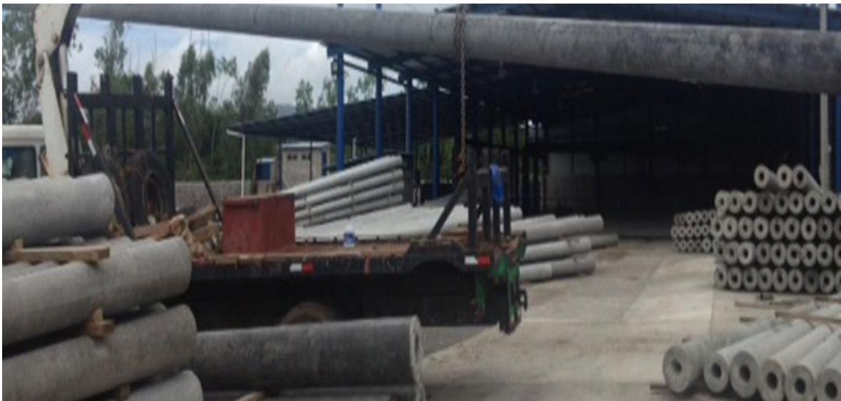
Figura 40 Traslado de postes
