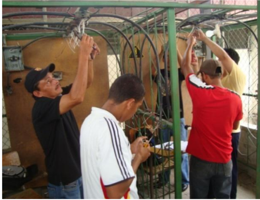
Internos en fase de confianza realizando prácticas de instalaciones eléctricas
