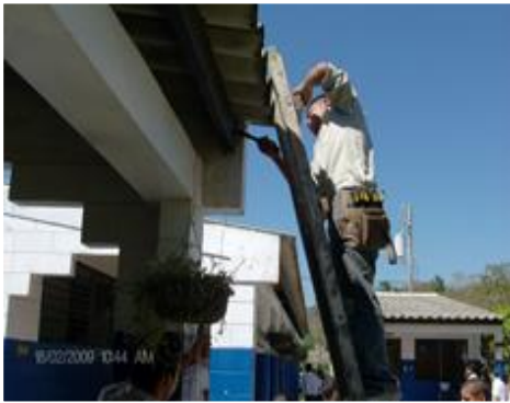
Estudiantes de ITCA-FEPADE realizando trabajos de instalaciones eléctricas
