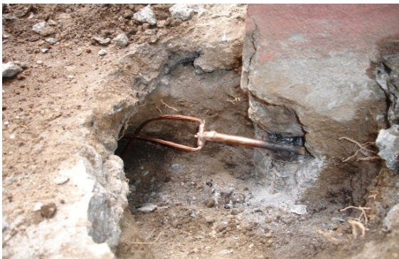
Fotografía 2. Instalación en Edificio E
