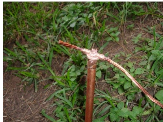
Fotografía 1. Unión por soldadura exotérmica.
