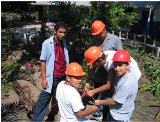
Estudiantes de ITCA – FEPADE realizan montajes de infraestructura eléctrica para el suministro de energía eléctrica a centros escolares públicos
