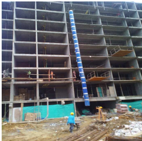
Ducto de escombros por fachada
