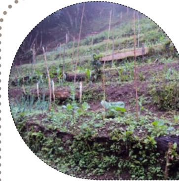
Figura 65 ▲ Implementación de huertas en zonas de alta pendiente utilizando técnicas de Bioingeniería. De esta manera se optimiza el uso del suelo, se estabiliza el terreno y se evita la erosión. Fuente de la imagen: <http://humedalcharcoazul.blogspot.com.co/2013/05/granja-manantial.html>.
