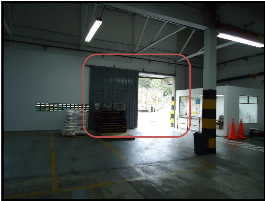
Ilustración 27 Puerta de acceso al almacén
