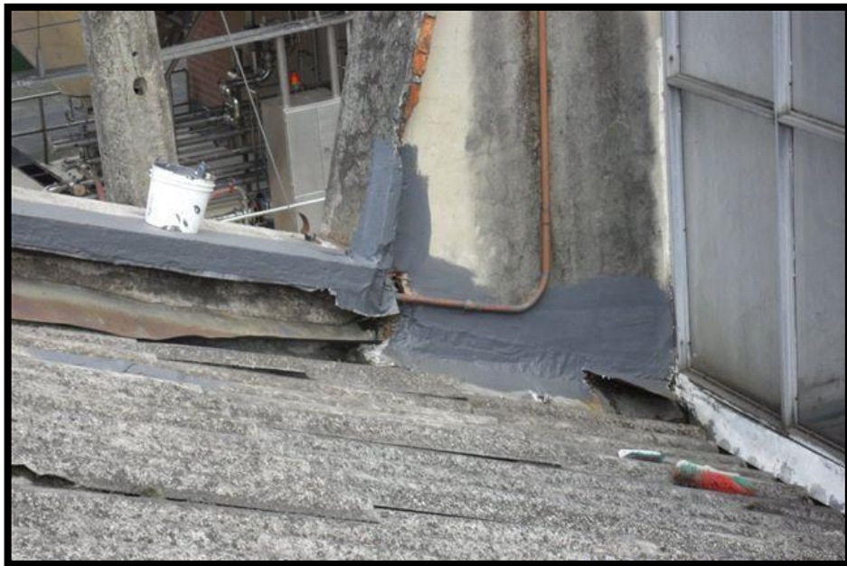
Ilustración 41 Arreglos en filtraciones de agua 2
