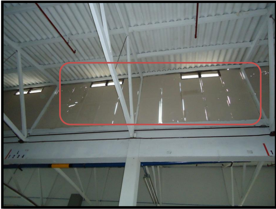
Ilustración 30 Ventanas del almacén
