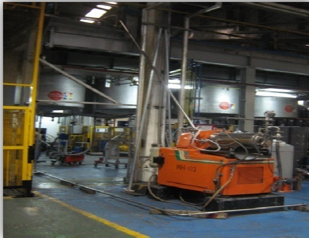
Imagen 24: Montaje de recirculación.
