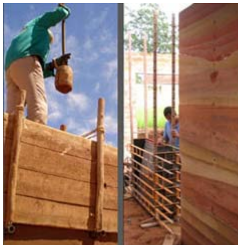
Imagen 2. Ejecución del sistema de tierra apisonada. Recuperado de: (Neves & Borges Faria, 2011)
