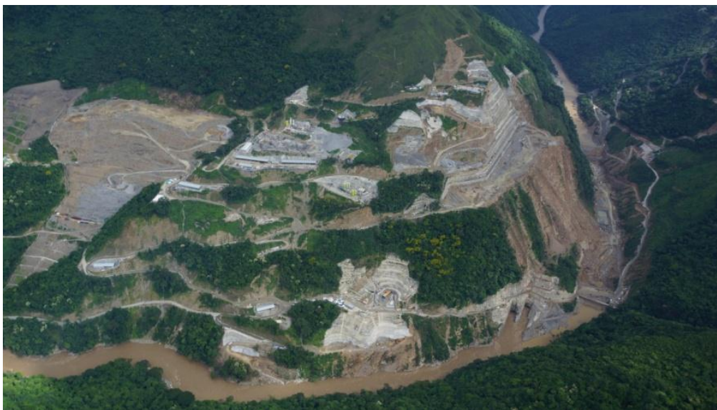
Figura 34. Vista general de las excavaciones después del desvío. Junio 9 de 2014. Fuente: cortesía del Consorcio CCC
