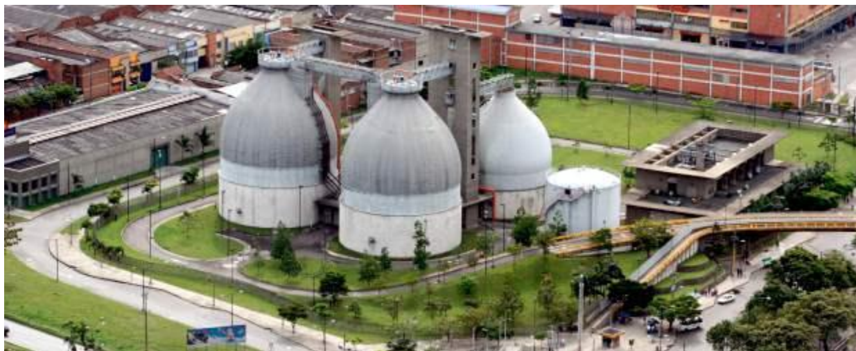
Figura 28. Planta de tratamiento de aguas residuales San Fernando 2011 . Fuente: Periódico El Colombiano - Donaldo Zuluaga
