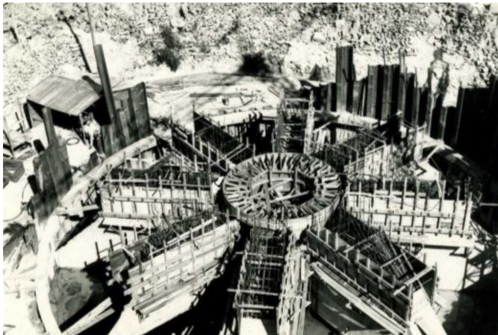
Figura 16. Represa Guatapé 1 –Torre de captación. Fuente: H. Arango – Archivo Familiar
