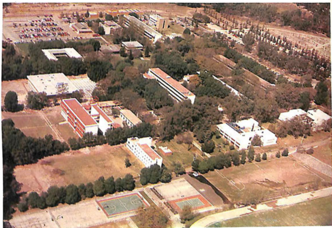
VISTA AEREA DEL CAMPUS.
