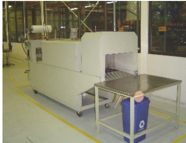
Ilustración 27. Túnel de termo encogido salón de mezclas.
