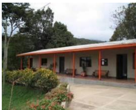
Ilustración 15 Escuela Reparada parque industrial La Pradera
