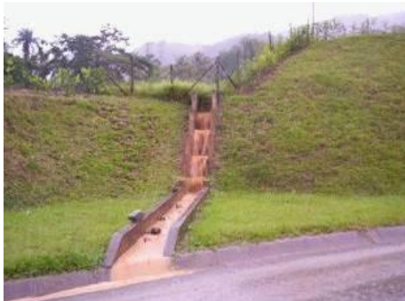
Ilustración 13 Sistemas de drenaje parque industrial La Pradera.
