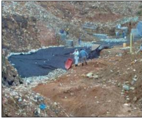
Ilustración 19 Adecuación Vaso la Carrilera
