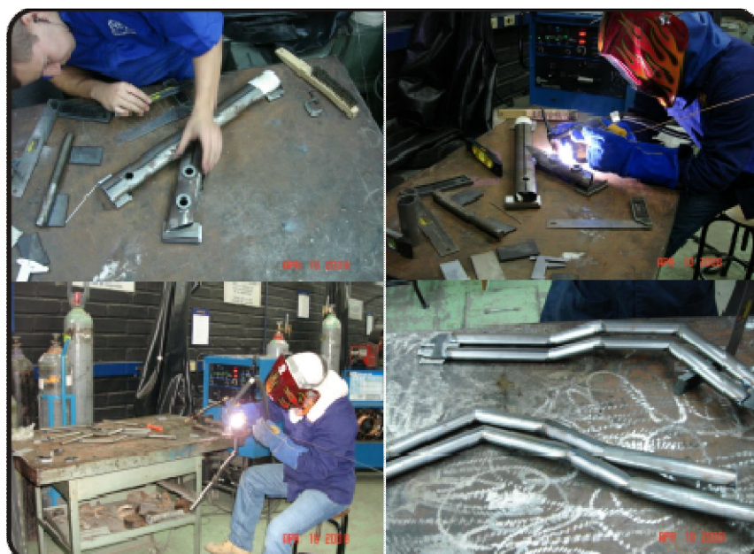
Figura 54. Proceso de soldadura marco y tijera
