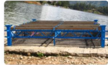
Paso3 Ensamble de mallas
