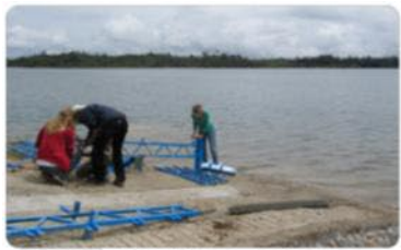
Paso1 Ensamble de cerchas a los apoyos
