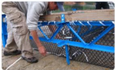
Paso4 Tejido de las mallas a la estructura
