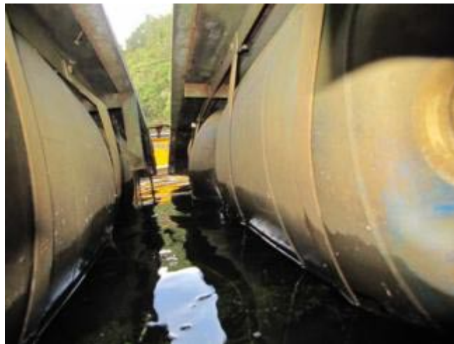
Ilustración 46. Amarre de las canecas a la estructura.
