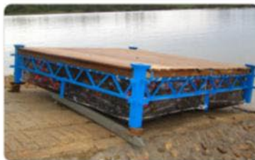
Paso7 Transportar el modulo al agua
