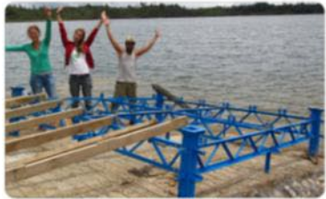
Paso2 Ensamble de los largueros a las cerchas
