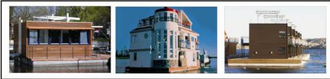
Ilustración 7 Estructuras flotantes de concreto aligerado.
