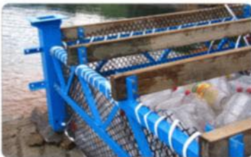
Paso5 Insertar el material flotante
