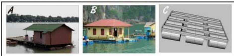
Ilustración 4 VIVIENDAS FLOTANTES EN CANECAS A. Vivienda flotando en canecas de acero. B. Vivienda flotando en canecas de poliestireno C. Modulación estándar de canecas.
