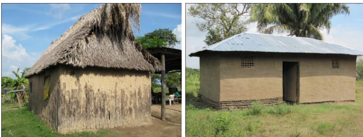
Ilustración 12. Vivienda típica de la zona
