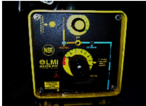
Figura 21. Bomba de dosificación.
