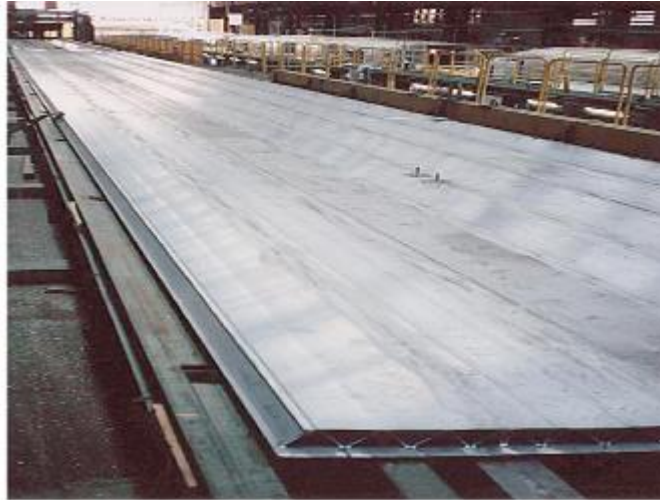
Ilustración 30. Superficie de una estructura de techo de doble piel interior
