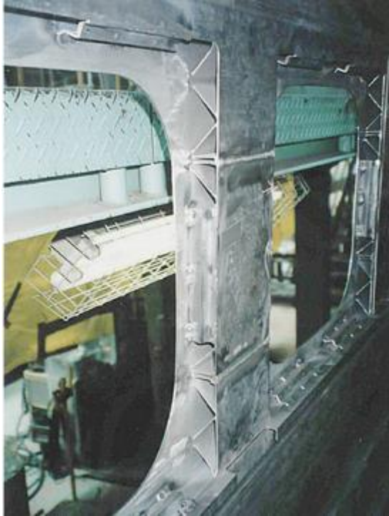
Ilustración 29. Interior de la estructura
