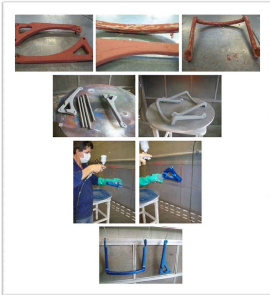
Imagen 37: Acabado final y pintura
