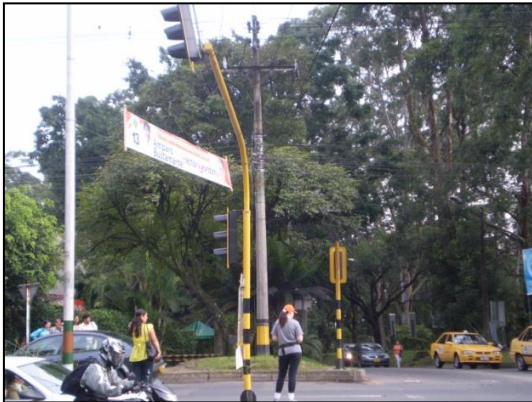
Figura 13. Falta de semáforo peatonal. Fuente: elaboración propia.
