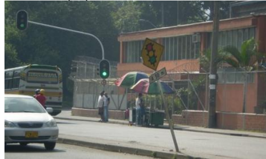
Foto 74. Mal estado de las señales. Fuente: elaboración propia.
