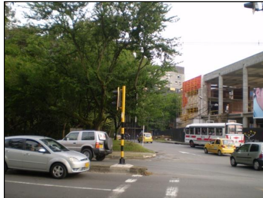
Figura 14. Falta de semáforo peatonal. Fuente: elaboración propia.
