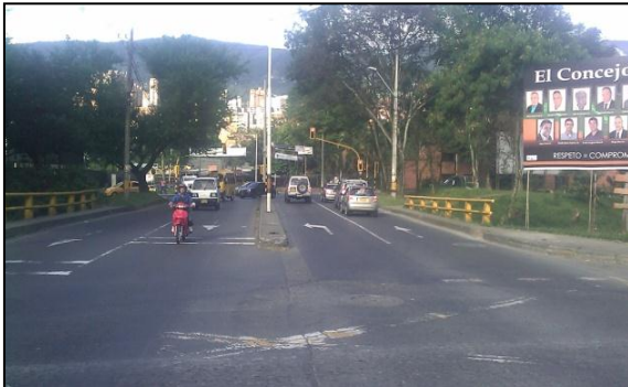
Foto 11. Estado de la pintura. Fuente: elaboración propia.
