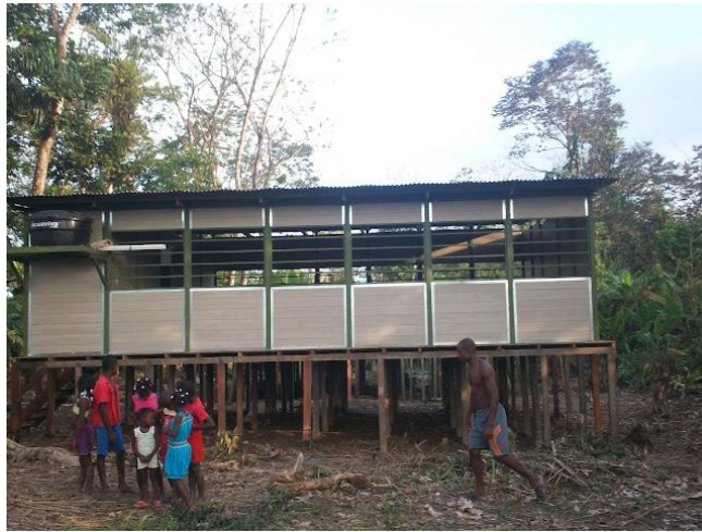
Figura 15. Viviendas fabricadas con el sistema WPC.
