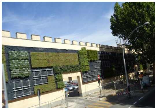
Figura 19. Muro verde en construcción en Budapest, Hungría.
