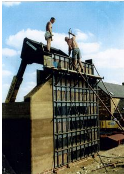
Figura 7. Trabajo australiano moderno de formaletería para el sistema de tapia
