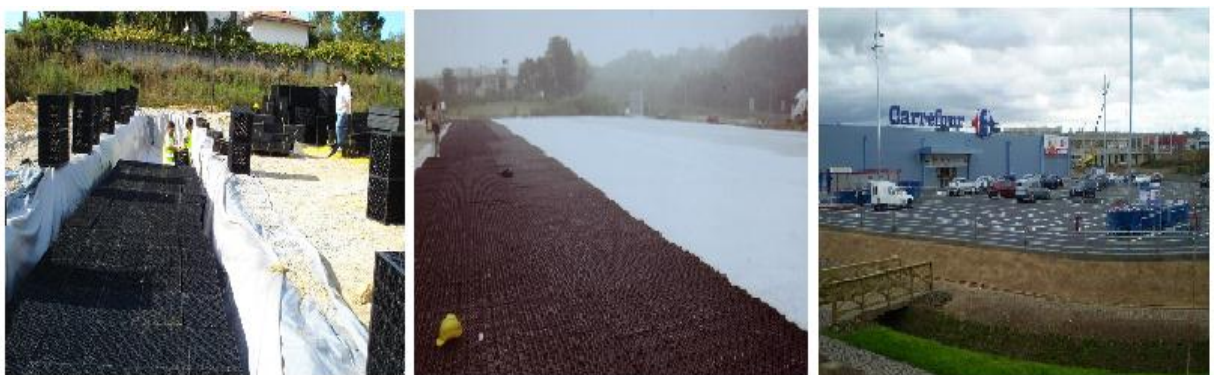
Figura 24. Proceso constructivo zona de parque permeable, La Coruña, España
