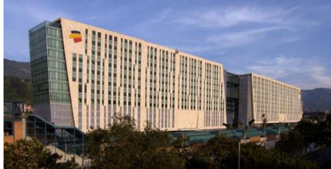
Figura 33. Edificio dirección general Bancolombia, Medellín
