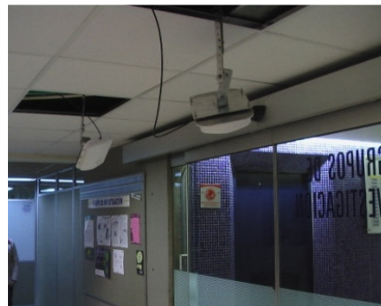
FIGURA 27 - INSTALACIÓN ANTENAS RFID
