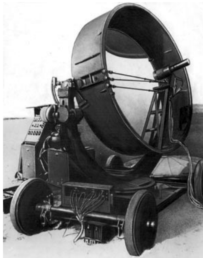
Рис. 2. Теплообнаружитель-пеленгатор ВЭИ с диаметром зеркала 150 см
