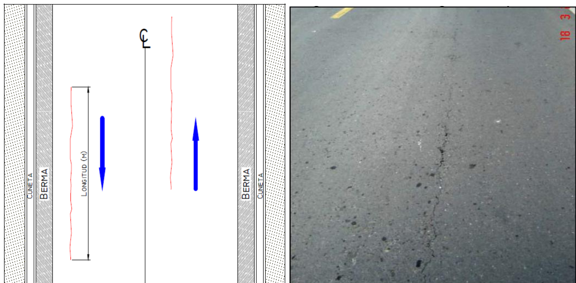
Figura 9. Fisuras Longitudinales.
