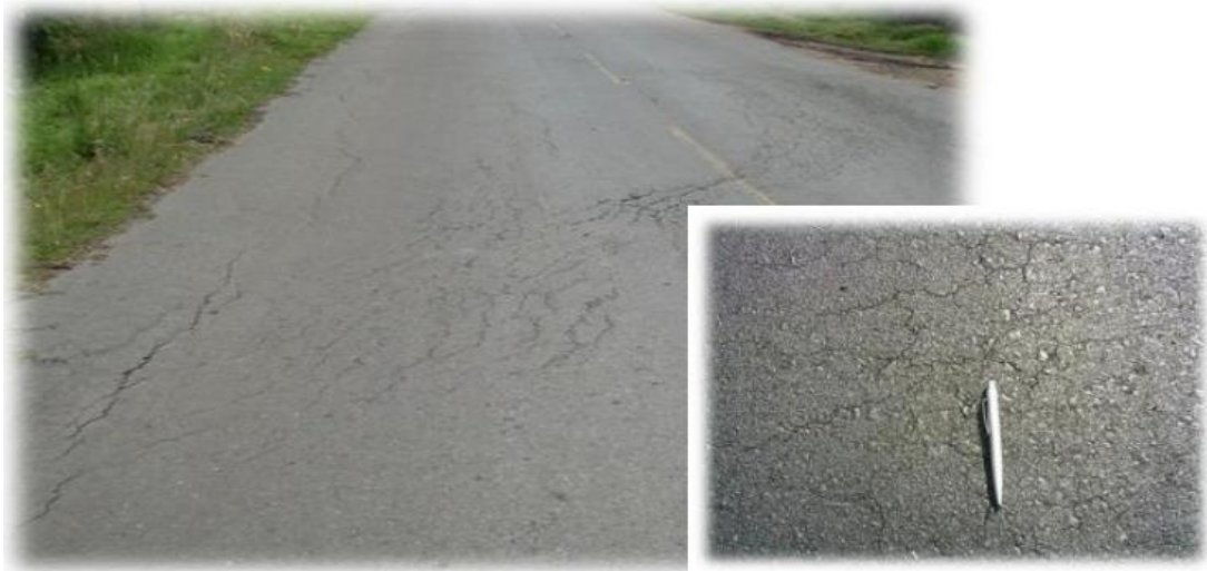
Figura 10. Fisuramiento Térmico.
