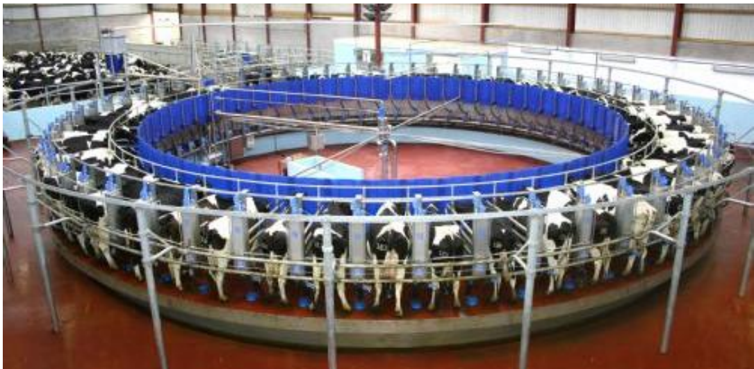
Figura 3. Instalación de equipo de ordeño fijo.
