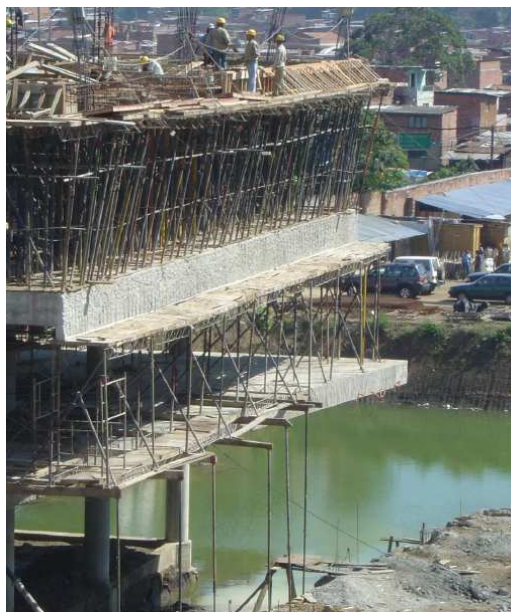
Figura 17. Foto de la obra parque explora
