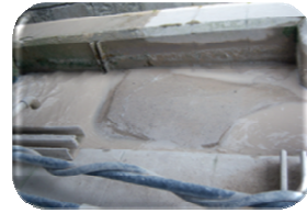
Daños y averías
