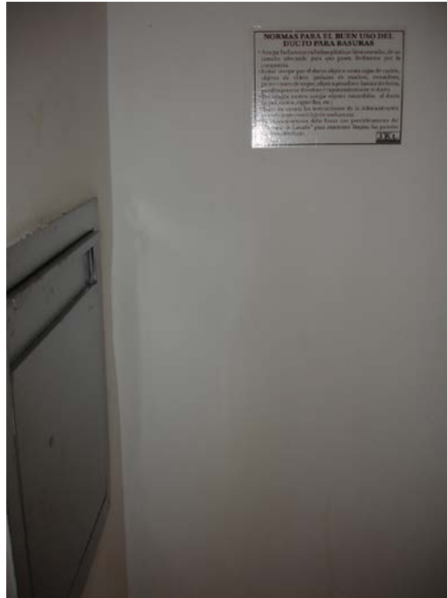
Área ducto de basuras
