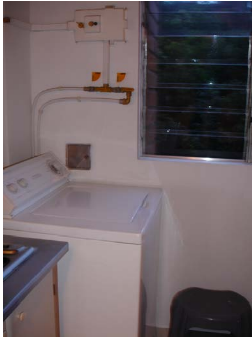
Área de lavandería
