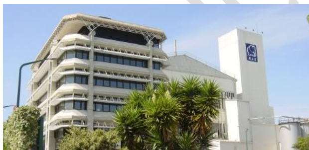
Figura 2.3- Instalações actuais da RAR [2]
