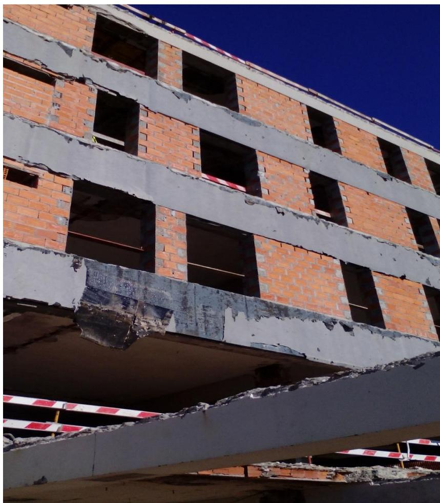
Fig. 52-Paredes exteriores de Edifício Frente Existente/Novo em alvenaria (foto do autor)
