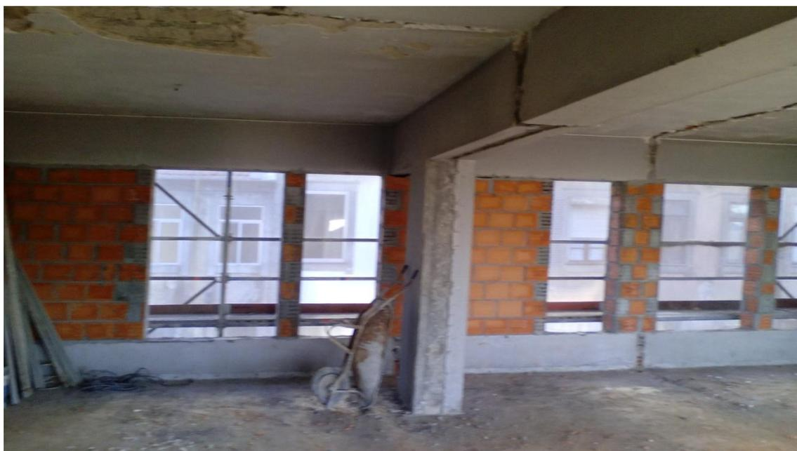
Fig. 19-Execução de paredes exteriores em alvenaria (foto do autor)
