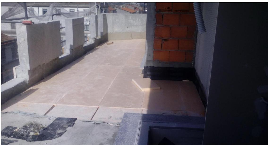
Fig. 27- Aplicação de tela de impermeabilização e isolamento térmico (foto do autor)
