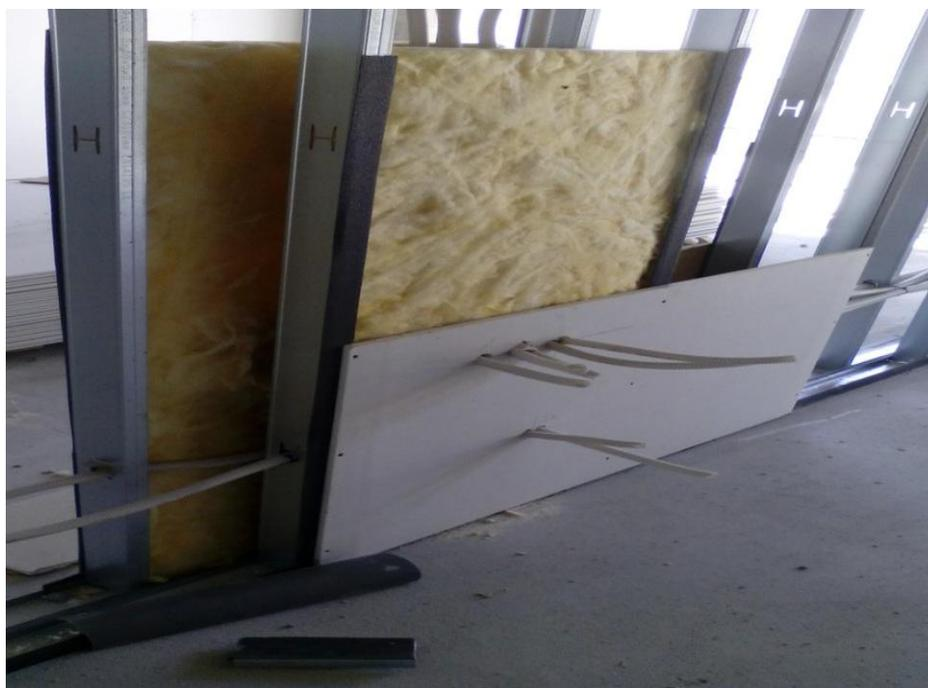
Fig. 67-Execução de parede interior em gesso cartonado (foto do autor)
