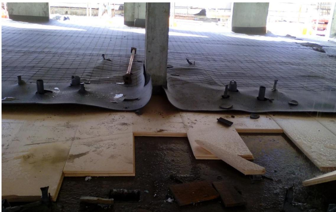
Fig. 18- Aplicação de membrana acústica (foto do autor)
