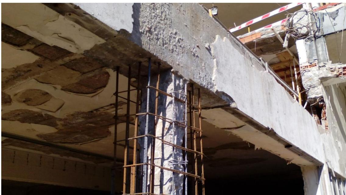
Fig. 16- Reforço de pilar existente (foto do autor)
