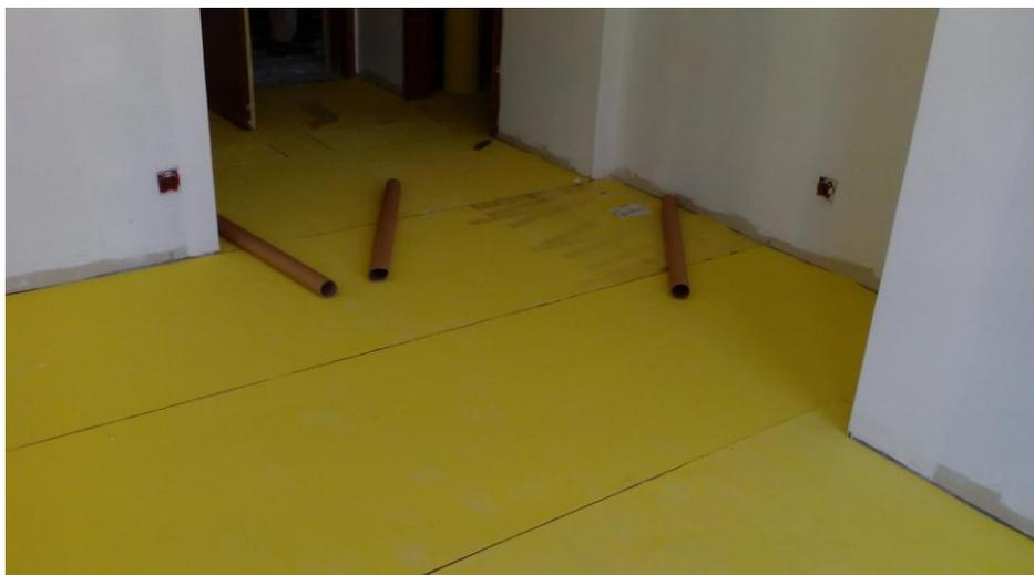
Fig. 75-Aplicação de isolamento acústico FONODAN 900 (foto do autor)
