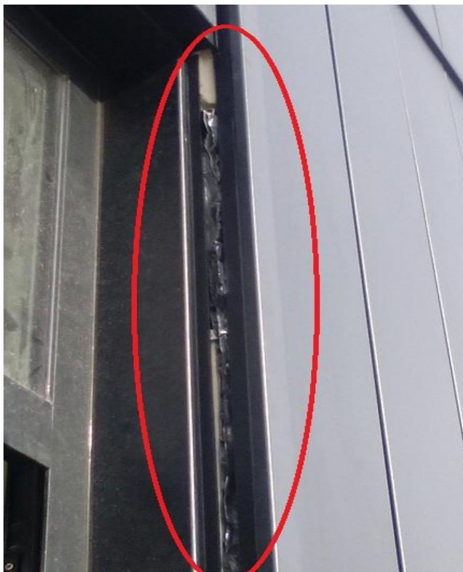
Fig. 60-Aplicação de isolamento térmico alternativo BOLTHERM (foto do autor)
