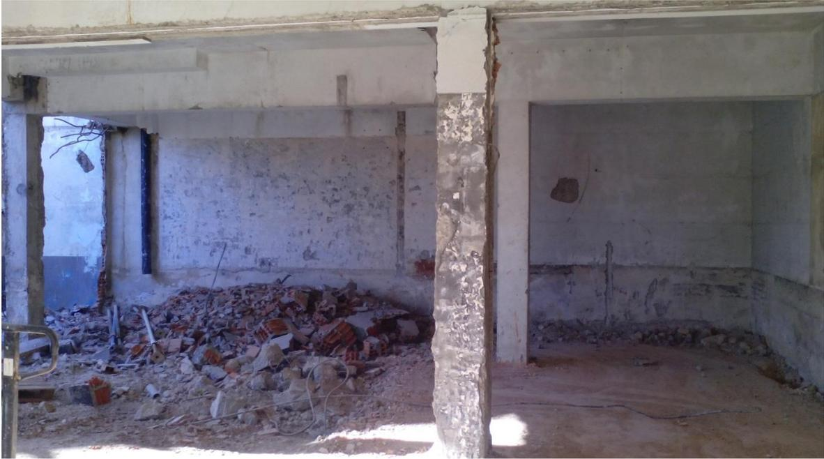
Fig. 56-Demolição de pavimento térreo Edifício Frente Existente (foto do autor)
