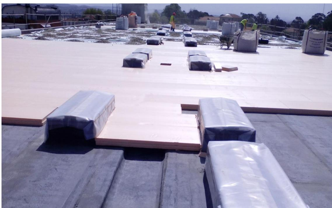
Fig. 26-Aplicação de isolamento térmico, manta geotêxtil e godo( foto do autor)
