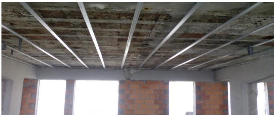
Fig. 81-Execução de estrutura para colocação de teto junto à laje para correcção de fissuras e buracos (foto do autor)
