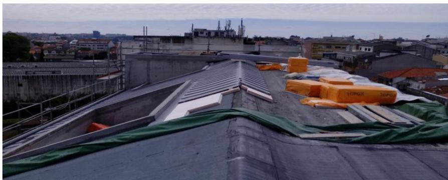
Fig. 28-Aplicação de zinco sobre tela de impermeabilização e isolamento térmico (foto do autor)
