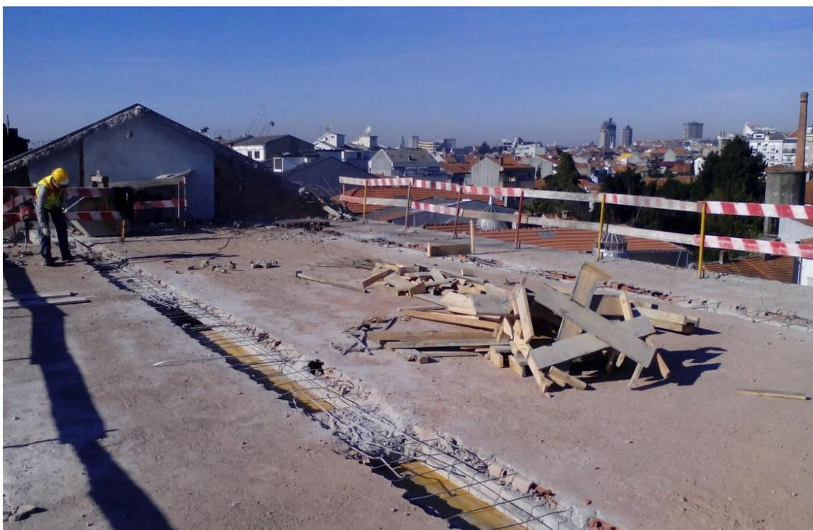
Fig. 36-Aberturas em laje aligeirada existente (foto do autor)
