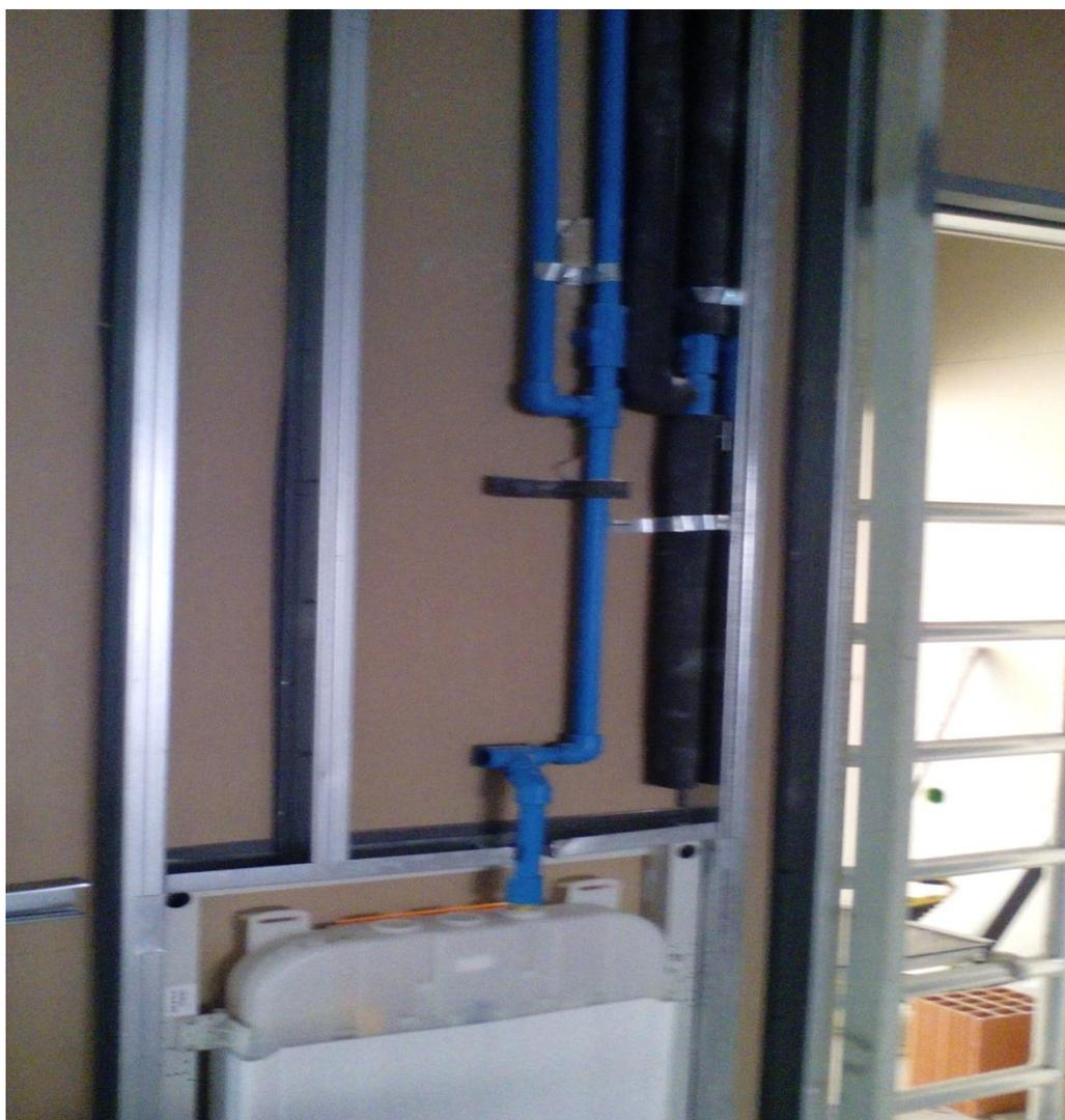
Fig. 40- Isolamento térmico de Tubagens com material ARMAFLEX (foto do autor)
