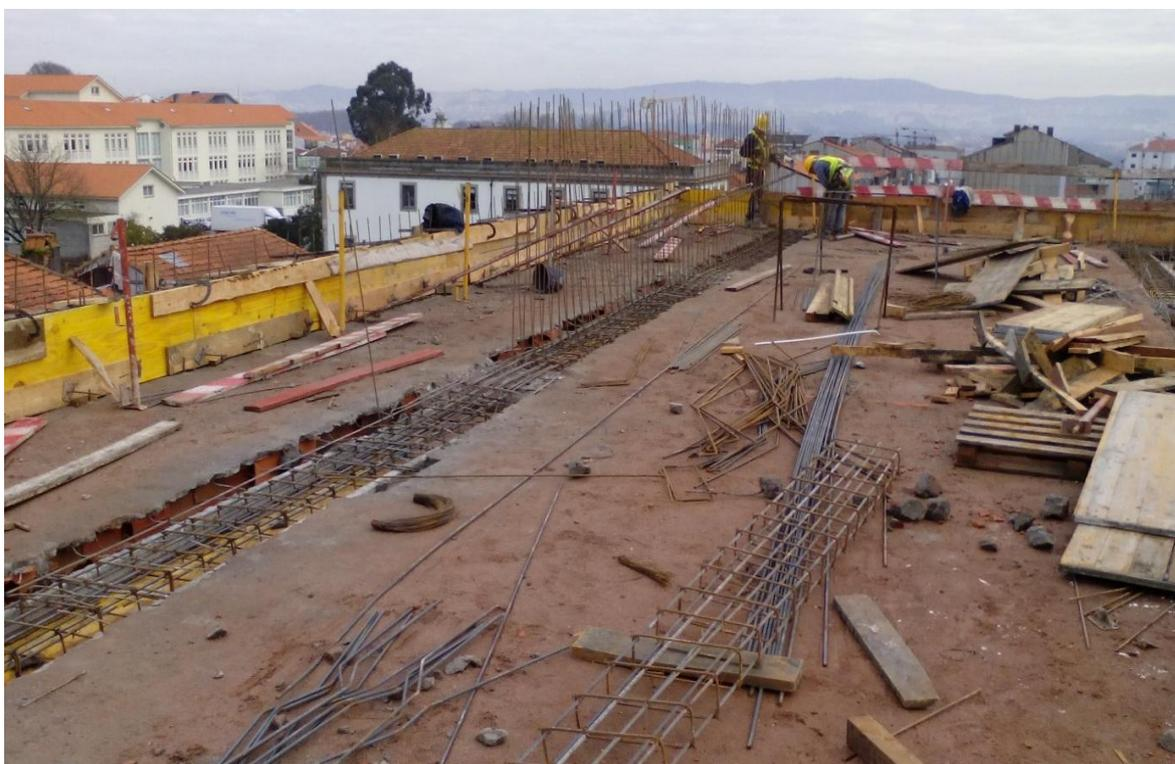
Fig. 37-Colocação de armadura de tarugos (foto do autor)
