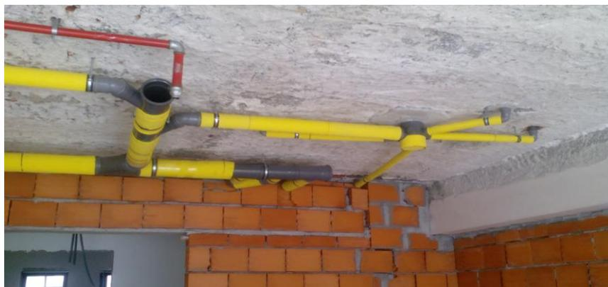
Fig. 85- Isolamento acústico em tubagens
