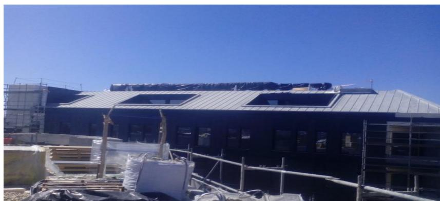
Fig. 29-Cobertura inclinada revestida em zinco (foto do autor)
