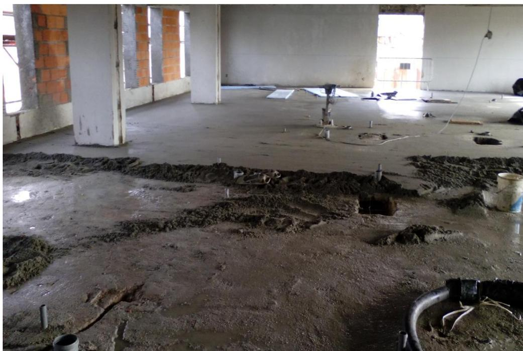
Fig. 23- Execução de pavimento em betonilha (foto do autor)
