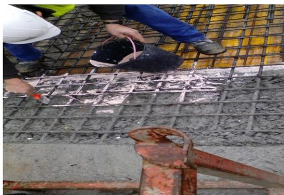
Fig. 32-Aplicação de Icosit em junta de betonagem (foto do autor)
