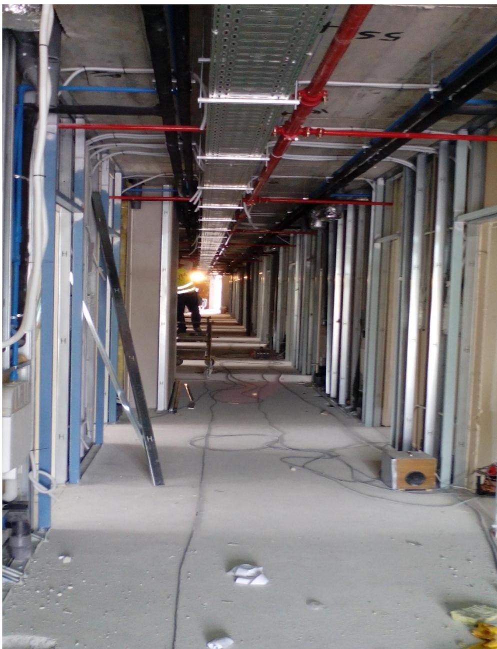
Fig. 41-Rede de abastecimento suspensa piso r/c (foto do autor)
