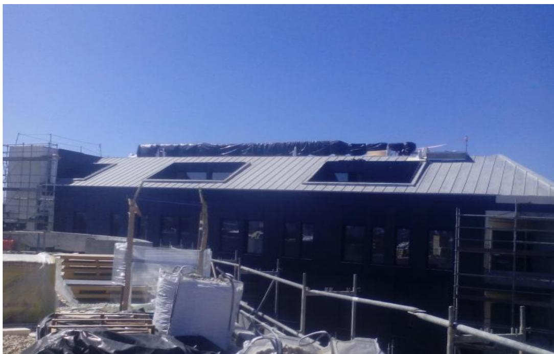
Fig. 47-Cobertura inclinada Edifício Frente Existente/Novo (foto do autor)
