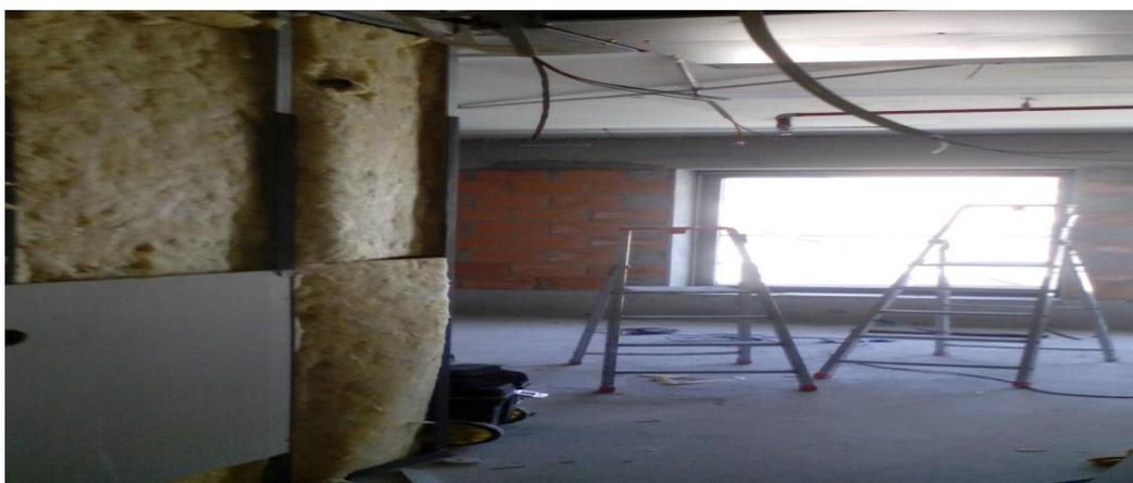
Fig. 64-Aplicação de isolamento acústico "lã de rocha" em paredes exteriores (foto do autor)
