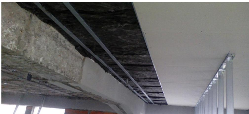
Fig. 82-Execução de teto com o objetivo de melhoria do isolamento acústico (foto do autor)
