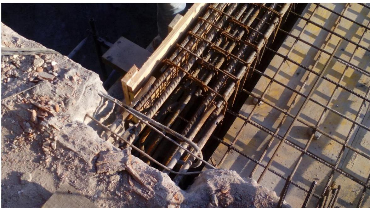
Fig. 34-Ligação entre estrutura existente e estrutura nova (foto do autor)
