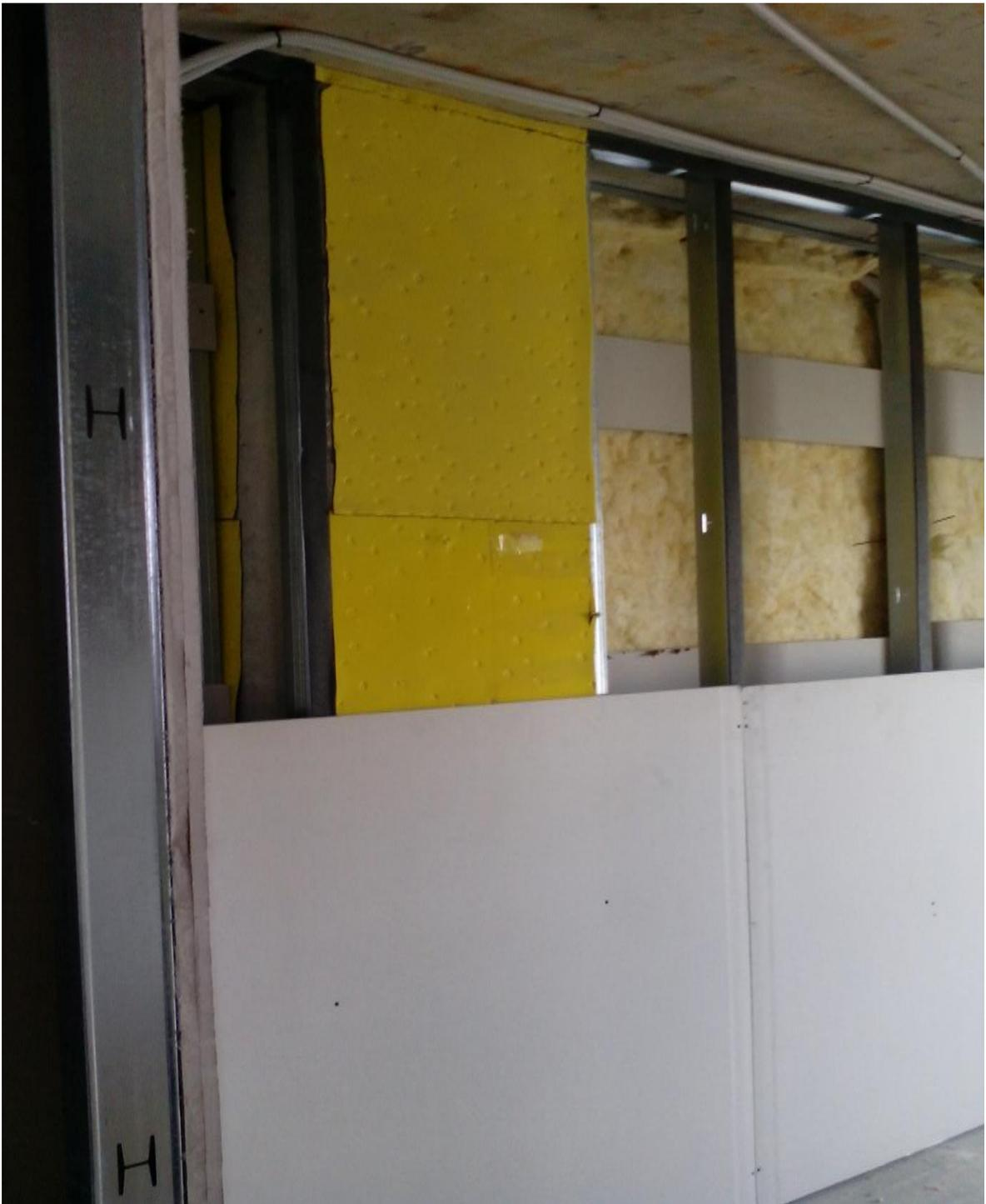
Fig. 84-Isolamento acústico em pilares
