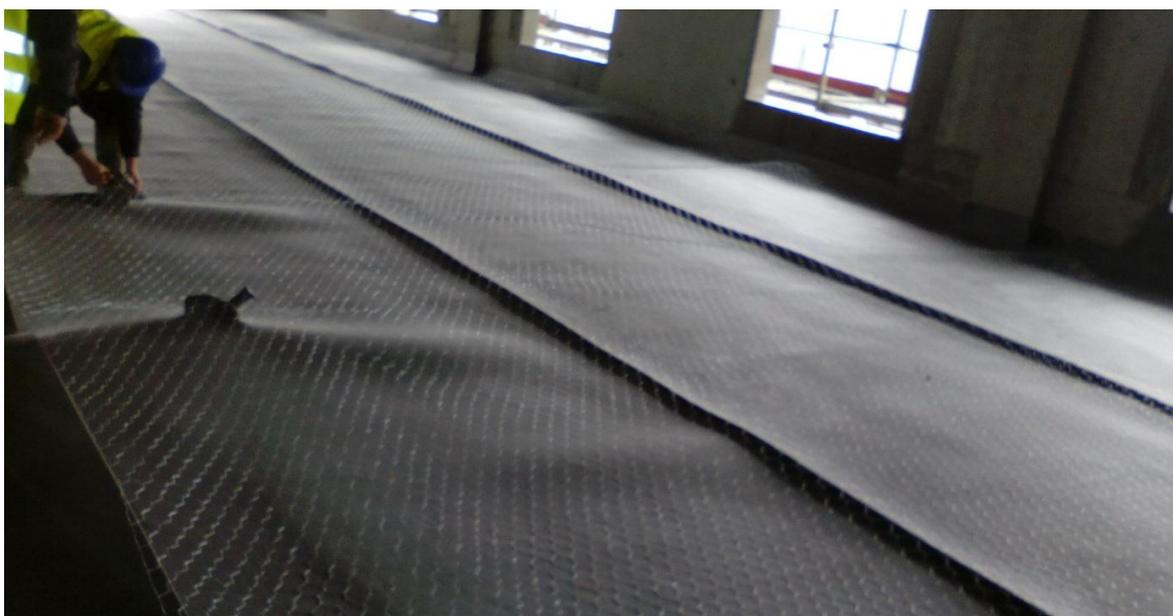
Fig. 78- Aplicação de isolamento acústico IMPACTODAN 10 (foto do autor)
