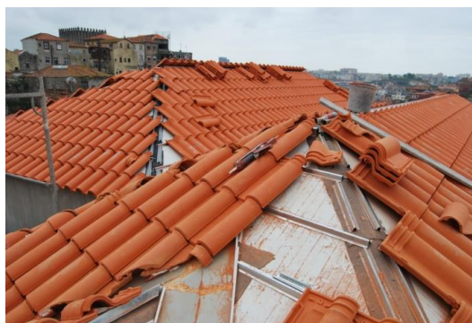
Figura 50 - Colocação da telha cerâmica
