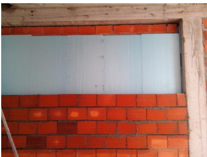
Figura 29 - Aplicação do isolamento XPS nas paredes interiores
