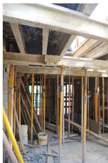
Figura 37 - Execução da laje do 2º piso
