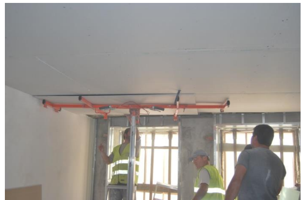
Figura 47 - Aplicação das placas de gesso cartonado no teto
