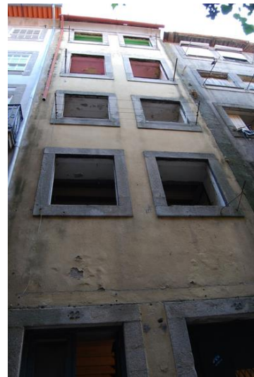
Figura 21 - Fachada da Rua Sant'Ana (Fonte: Porto Vivo, SRU)
