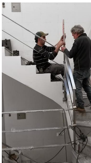
Figura 66 - Aplicação dos corrimões
