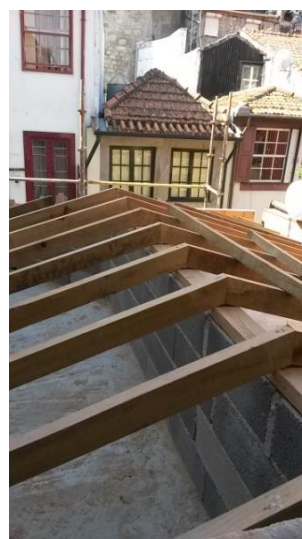
Figura 30 - Asnas de madeira na cobertura
