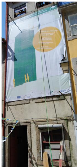
Figura 20 - Fachada do Largo da Penaventosa (Fonte: Porto Vivo, SRU)
