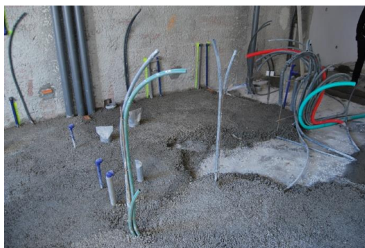
Figura 41 - Colocação da argamassa de regularização
