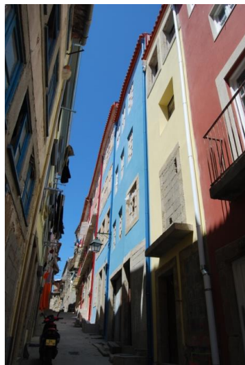
Figura 52 - Fachada principal pintada
