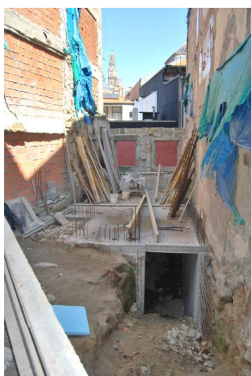
Figura 36 - Laje do 1º piso concluída
