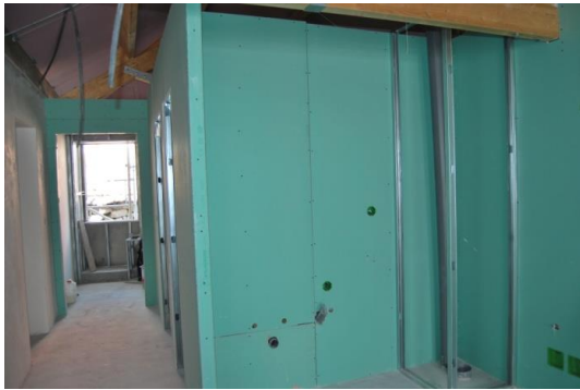
Figura 44 - Paredes divisórias em placas de gesso cartonado
