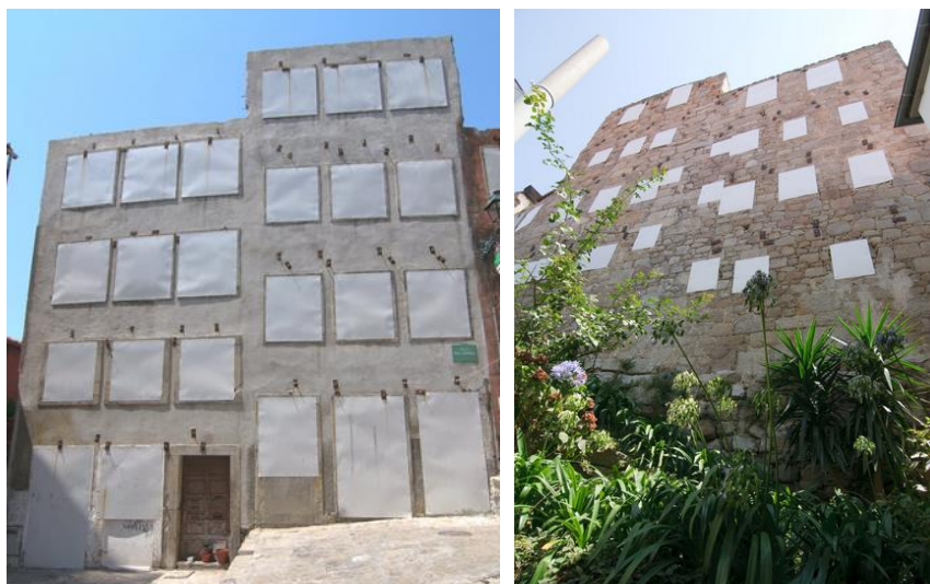
Figura 25 - Fachada principal e tardoz (Fonte: Porto Vivo, SRU)
