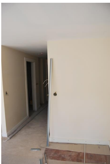
Figura 64 - Vista dos aros e rodapés
