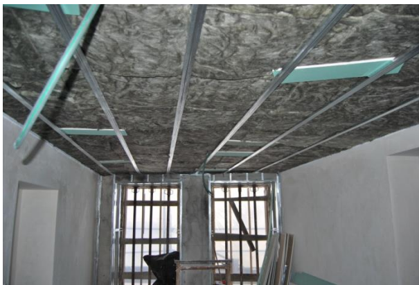
Figura 46 - Colocação de lã de rocha
