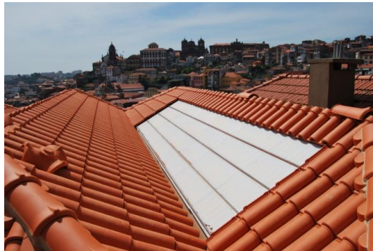
Figura 51 - Telhado concluído com espaço para a receção dos coletores solares
