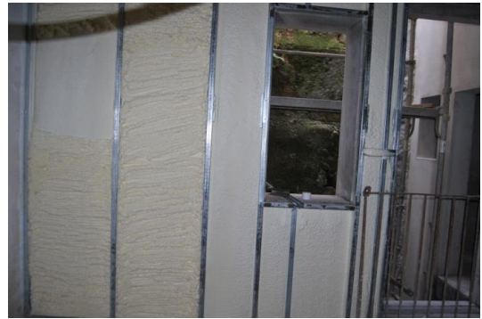
Figura 45 - Poliuretano projetado
