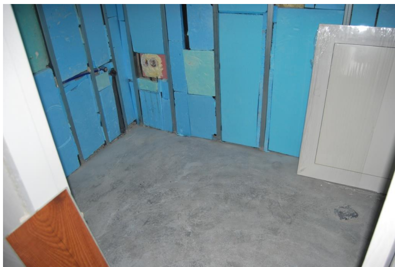
Figura 58 - Execução das paredes
