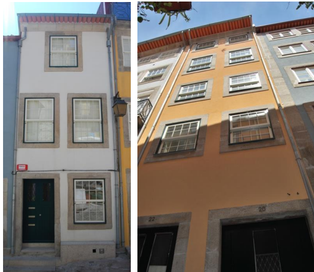
Figura 24 - Fachada principal e tardoz concluídas
