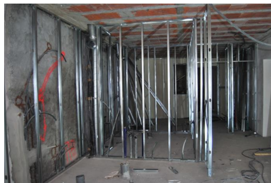
Figura 43 - Sistema de perfis metálicos
