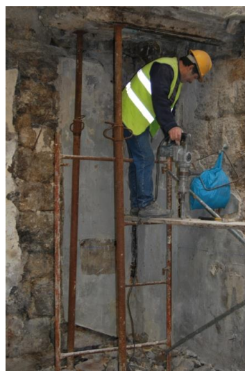
Figura 10 - Picagem das paredes
