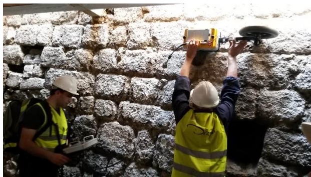
Figura 12 – Ensaio não destrutivo
