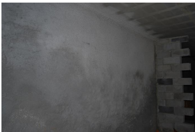
Figura 31 - Aplicação de betão projetado
