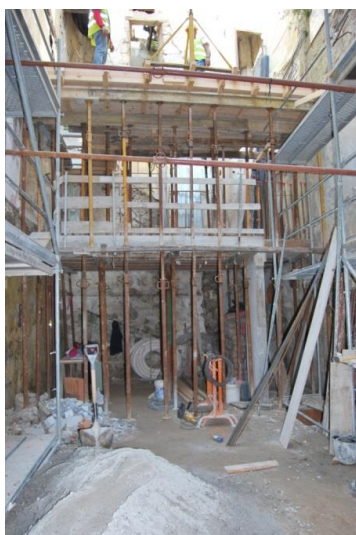
Figura 9 - Escoramentos e execução da laje do 2º Piso
