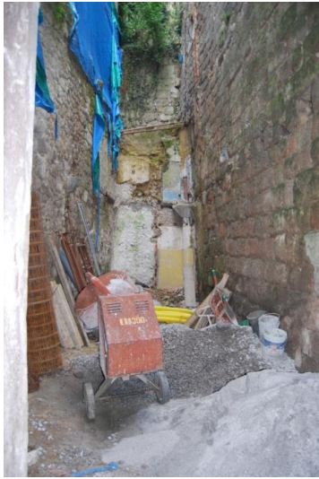
Figura 16 - Início dos trabalhos
