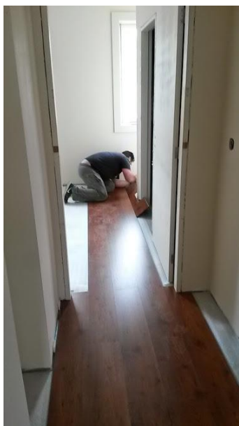
Figura 62 – Aplicação do piso flutuante
