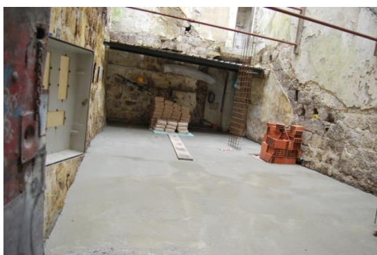
Figura 7 – Laje de piso
