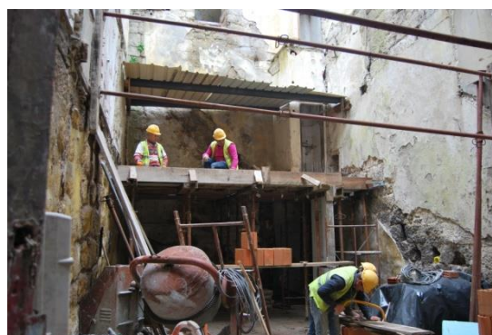
Figura 8 - Execução da laje do 1º Piso
