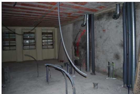
Figura 42 - Laje de piso concluída
