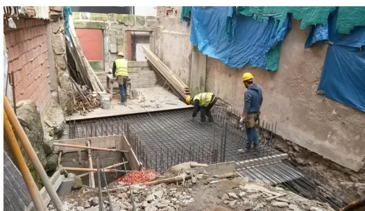
Figura 35 - Colocação da armadura para execução da laje
