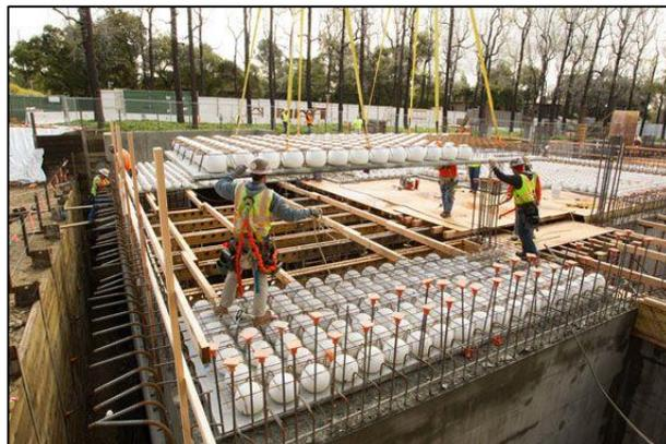
Figura 2.3 – Solução de aligeiramento - Sistema Bubbledeck.
