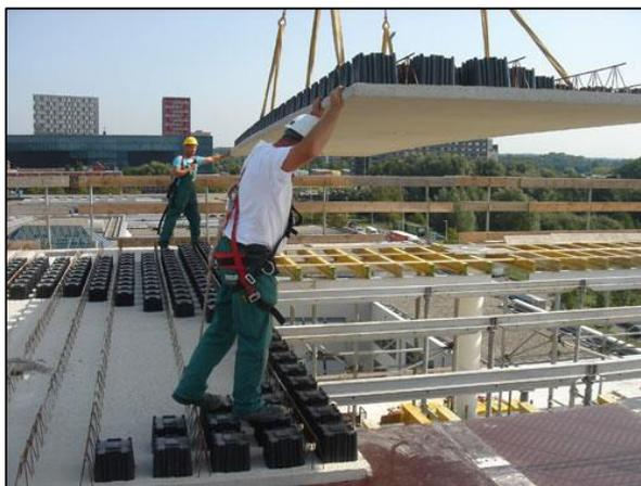
Figura 2.5 – Solução de aligeiramento - Sistema AirDeck [6]
