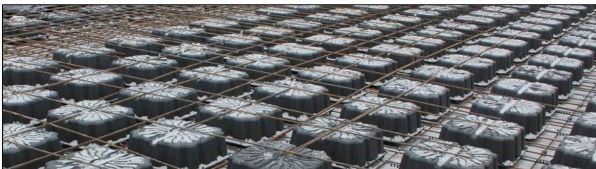
Figura 3.3 – Soluções de aligeiramento Ferca - Sistema Nautilus [3]
