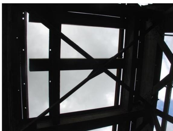
Figura 3.7 - Contraventamento horizontal superior
