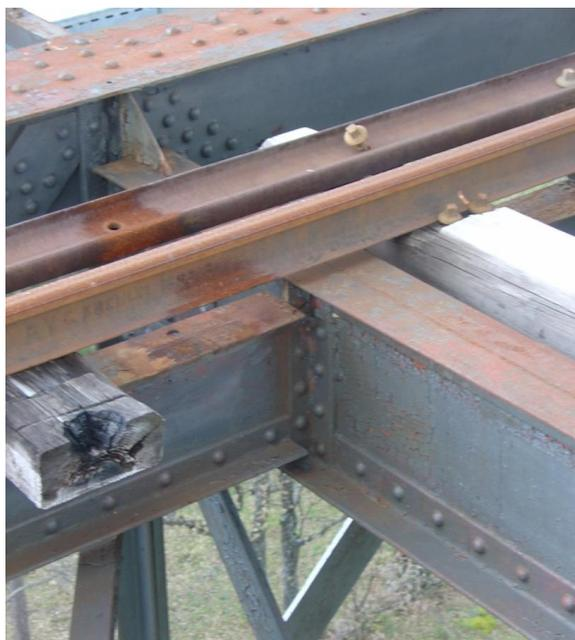
Figura 3.3 - Sistema de suporte dos carris e pormenor de ligação das longarinas com as carlingas
