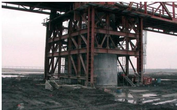
Figura 1.5 - Estrutura de suporte temporária da superestrutura (Pu, 2007)
