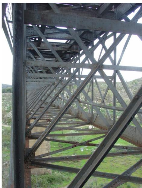
Figura 3.6 - Contraventamentos horizontal inferior e vertical
