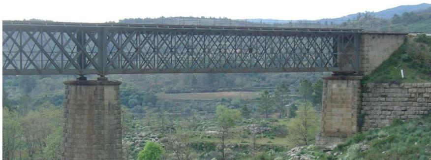
Figura 3.8 - Vista geral de um tramo extremo da ponte onde se podem identificar os aparelhos de apoio
