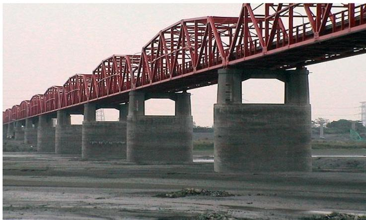
Figura 1.4 - Efeito da erosão na ponte (Pu, 2007)
