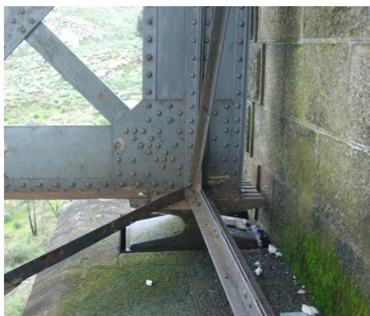
Figura 3.9 - Pormenor de um aparelho de apoio
