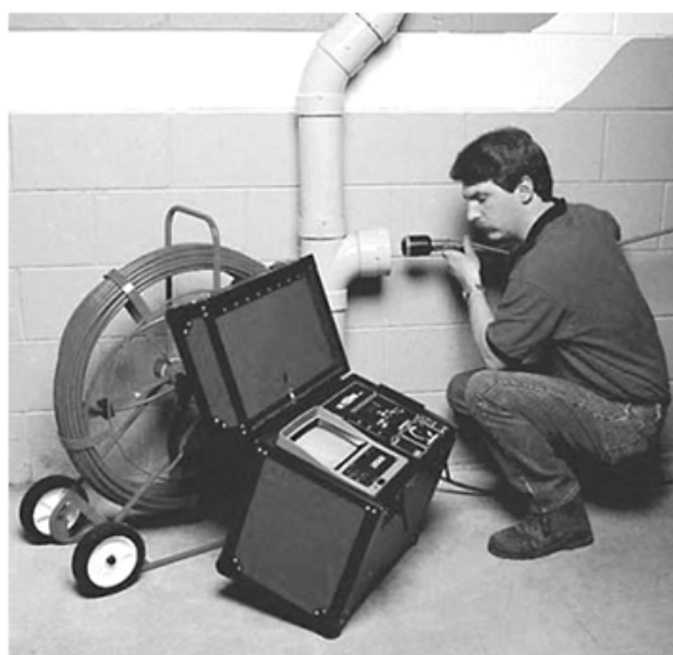
Figura 4.15 Camara montada numa haste rígida (Fonte: ASCE, 2009)
