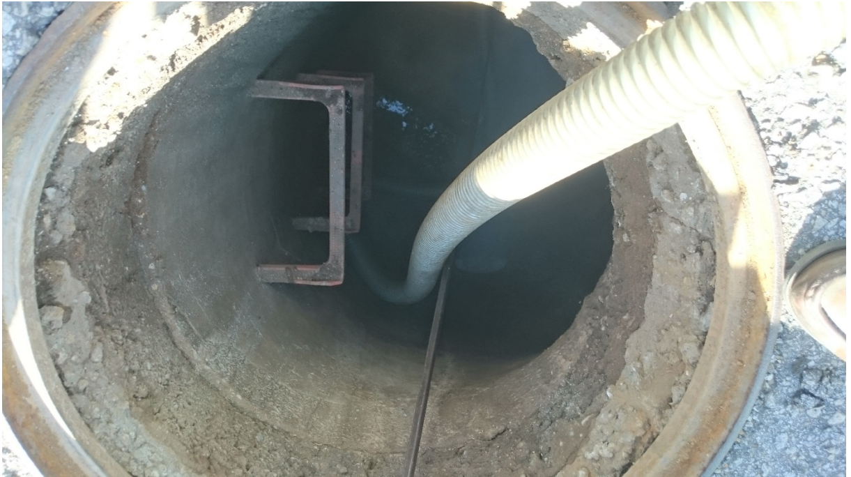
Ilustração 23 Tubo da máquina de fumo inserido na rede
