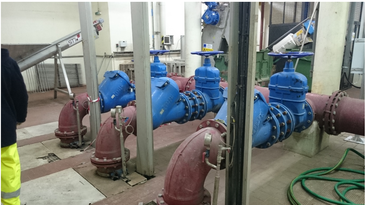
Ilustração 14 – Conduitas de compressão e respetivos acessórios
