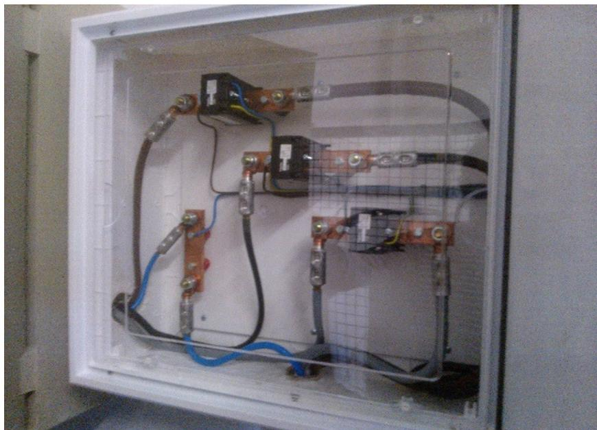
Figura 2.42 - Caixa ISM para instalação dos TI's de contagem de corrente indireta.
