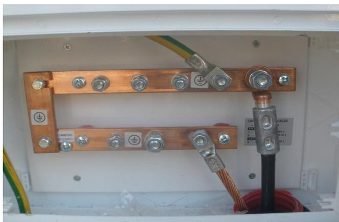
Figura 2.43 - Caixa de medição de terra para interligação das terras de proteção.
