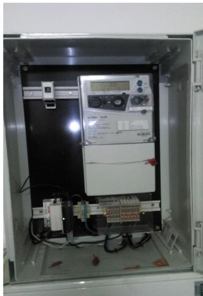
Figura 6.68 - Contador Bidirecional e Modem Gsm
