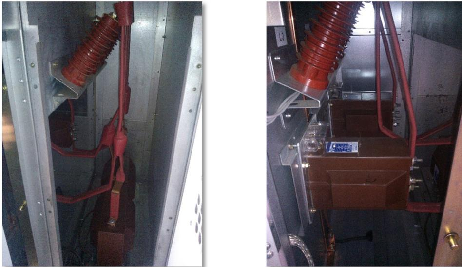
Figura 6.46 - TT's e TI's de Contagem
