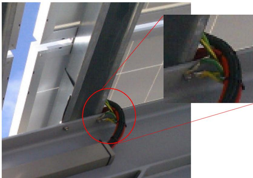
Figura 6.11 - Interligação das terras com a estrutura.
