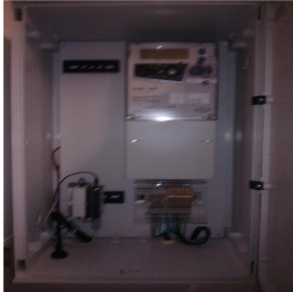
Figura 6.13 - Caixa de Contagem DMA-C17-510/N da EDP.
