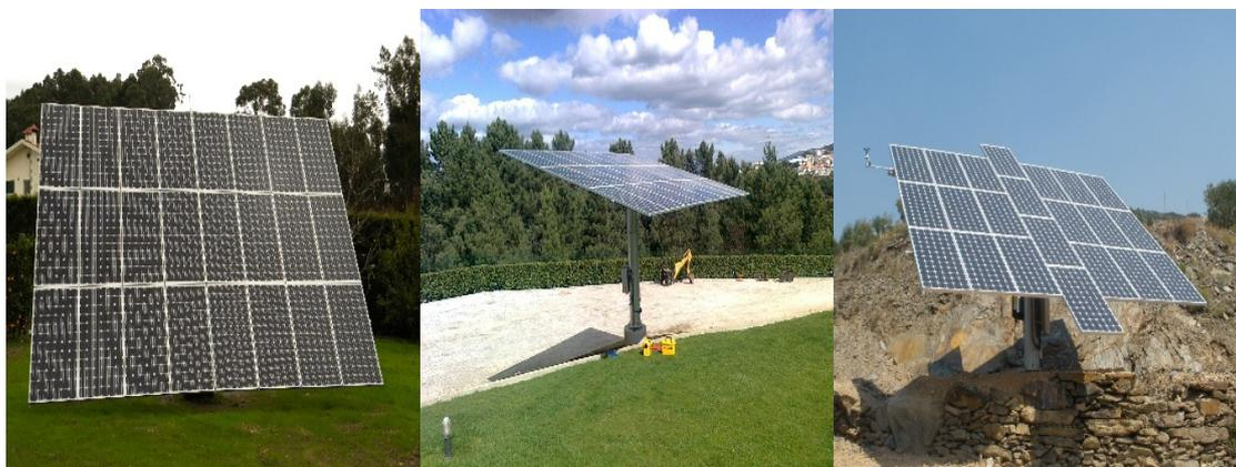
Figura 2.17 - Exemplos de Estruturas de Seguidor Solar
