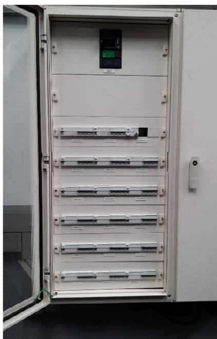
Figura 2.36 - Exemplo de um quadro geral de baixa tensão de minigeração.
