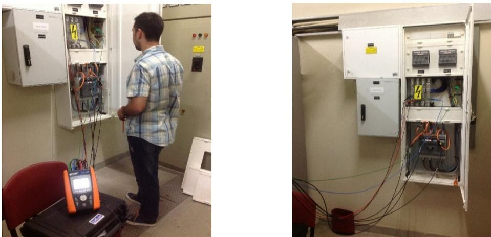
Figura 6.17 - Instalação do Analisador de Energia.
