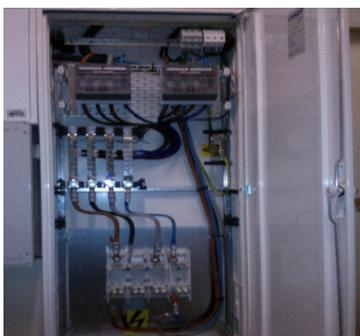
Figura 6.9 - Quadro Geral de Baixa Tensão de Minigeração
