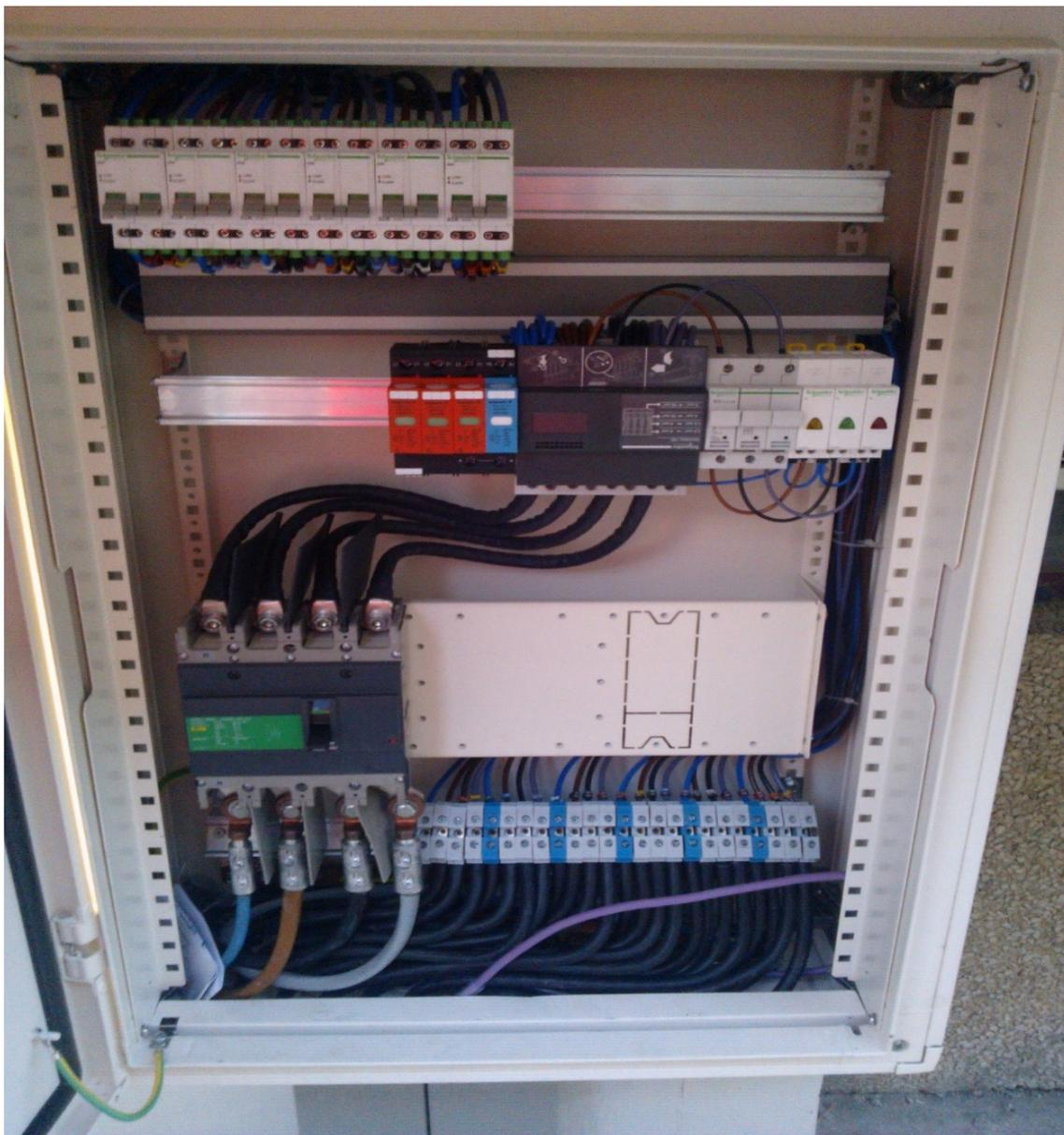
Figura 2.34 - Exemplo de um quadro parcial por edifício.
