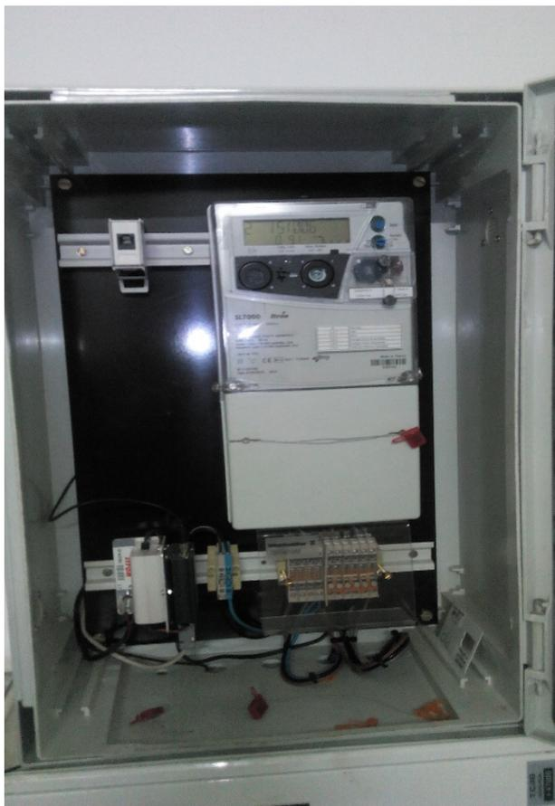
Figura 2.41 - Contador Bidirecional trifásico com modem GSM.
