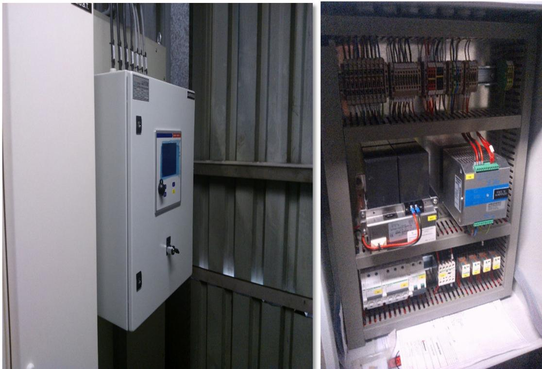
Figura 6.50 - Relé de Proteção de Interligação com a RESP
