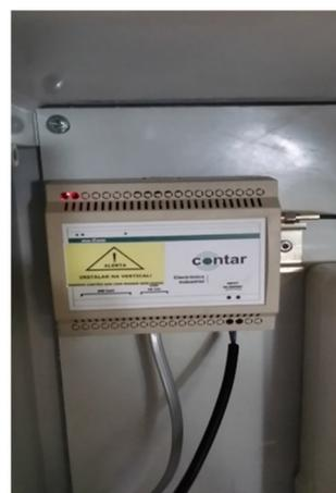
Figura 6.45 - Contador Bidirecional e Modem GSM.
