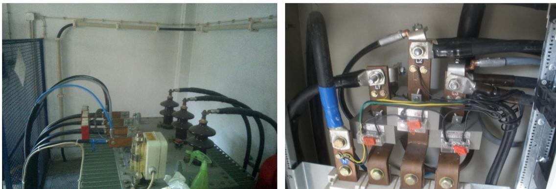
Figura 2.37 - Exemplo de ligação do ponto de interligação de uma central de minigeração.
