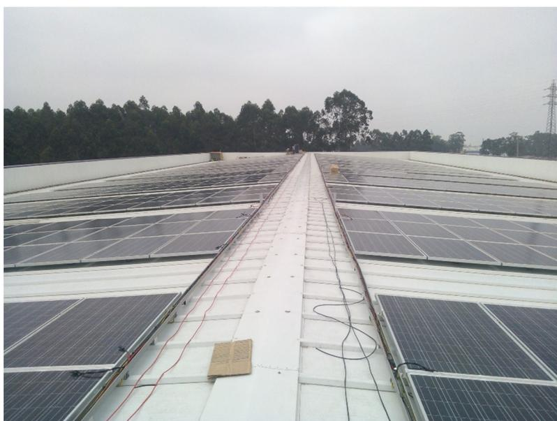
Figura 6.39 - Imagem Estrutura Complanar.
