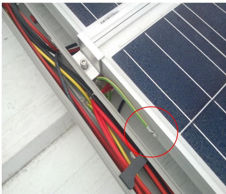
Figura 6.44 - Interligação das Terras com a Estrutura
