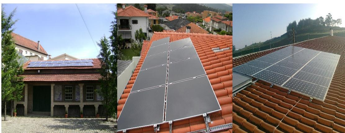
Figura 1.11 - Exemplos de Estruturas Complanares.
