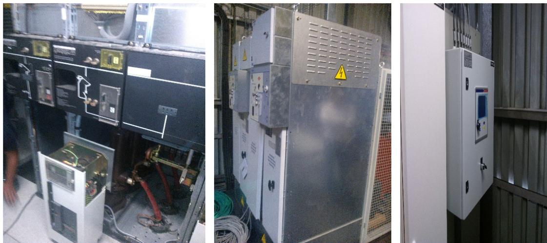
Figura 2.39 - Exemplo de alteração do Quadro de Média Tensão para instalação de uma central de minigeração.
