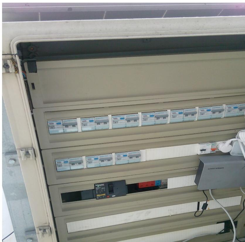
Figura 6.64 - Quadro Geral de Baixa Tensão de Minigeração
