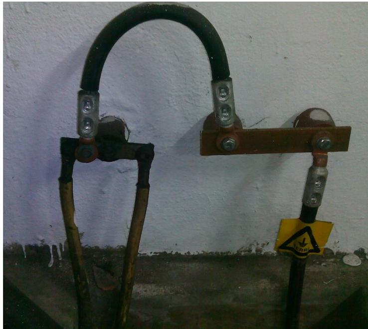
Figura 6.65 - Caixa de Medição de Terra de Minigeração.
