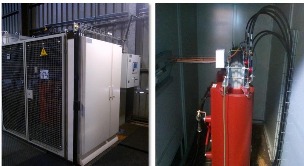
Figura 6.48 - PT de 250kVA de Minigeração
