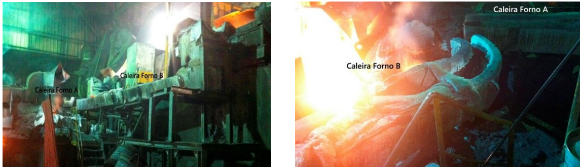
Figura 28 e 29 - Caleiras do Forno A e B
