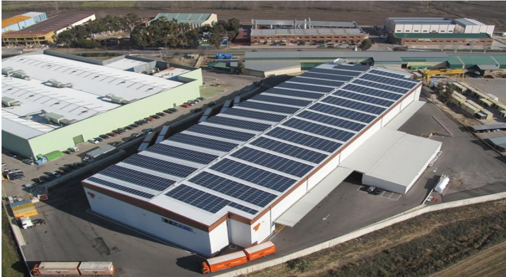
Figura 1 Sistema fotovoltaico em cobertura industrial [1]
