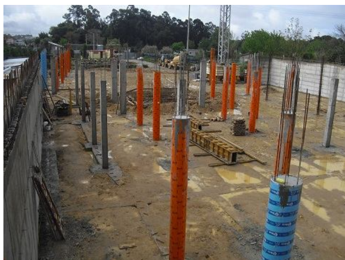
Figura 17 - Vista geral da execução de fundações e pilares: Corpo Esquerdo (cedida pela empresa)
