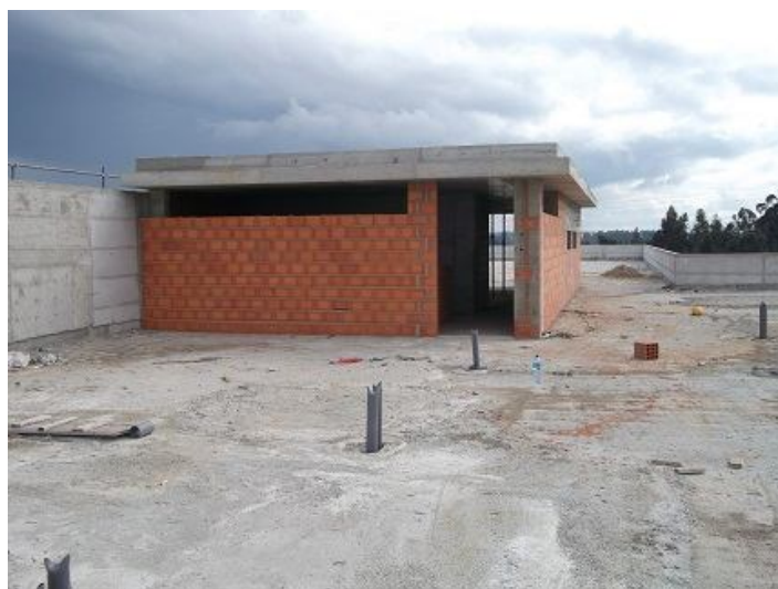
Figura 21 - Vista geral da laje de cobertura (cedida pela empresa)
