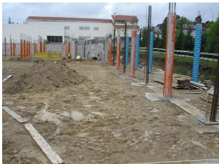
Figura 16 - Vista geral da execução de fundações e pilares: Corpo Direito (cedida pela empresa)
