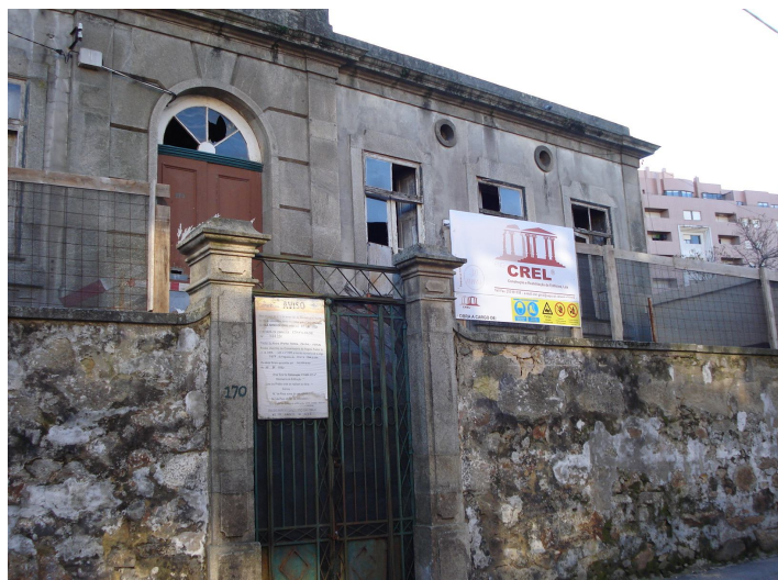
Figura 8 - Fachada do edifício existente: Corpo 1 (cedida pela empresa)
