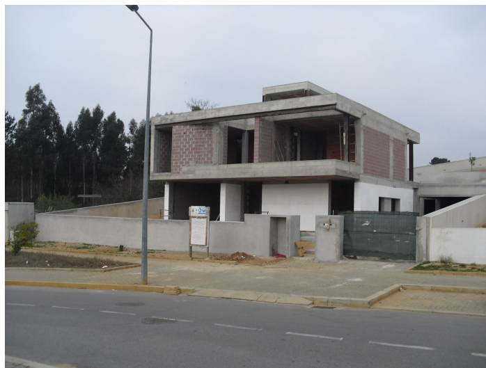
Figura 34 - Alçado frontal: estado atual da empreitada (cedida pela empresa)
