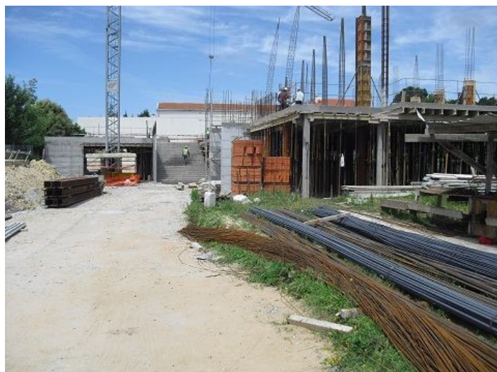
Figura 18 - Vista geral de laje ao nível do 1º andar (cedida pela empresa)
