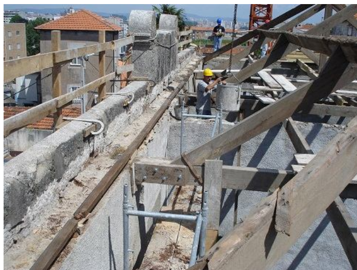
Figura 10 - Reabilitação de estrutura de cobertura: Corpo 1 (cedida pela empresa)
