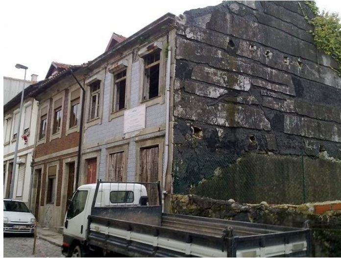
Figura 48 - Fachada do edifício existente antes da intervenção (cedida pela empresa)
