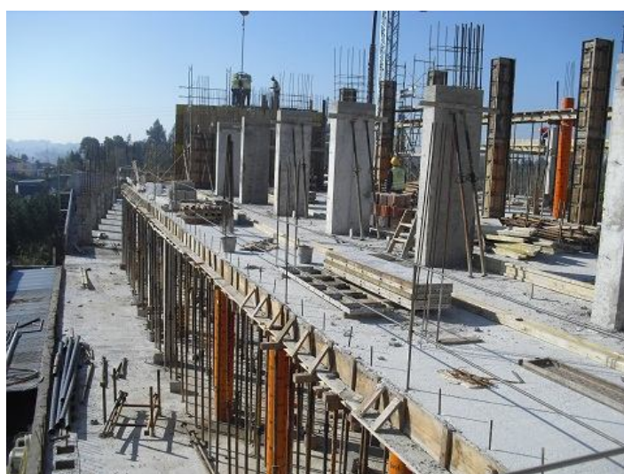
Figura 19 - Execução de Pilares ao nível do 2º Andar: Corpo Esquerdo (cedida pela empresa)
