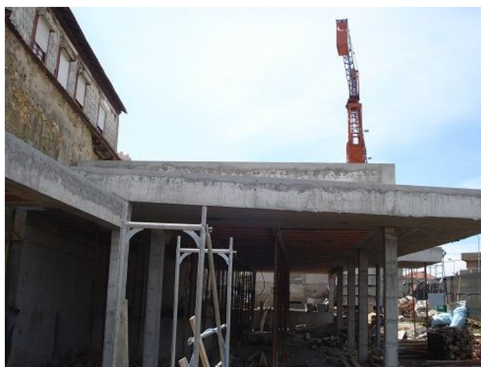
Figura 11 - Corpo 2 em fase de construção (cedida pela empresa)
