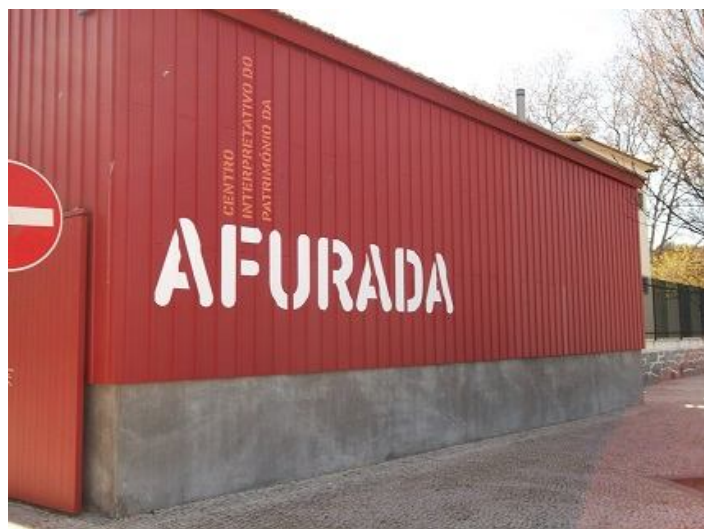
Figura 7 - Aspeto exterior do edifício após reconstrução: Alçado Noroeste (cedida pela empresa)
