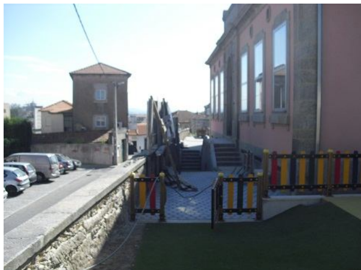
Figura 12 - Execução de arranjos exteriores em área envolvente do Corpo 1 (cedida pela empresa)
