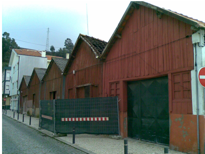
Figura 1 - Aspeto exterior do edifício existente (cedida pela empresa)
