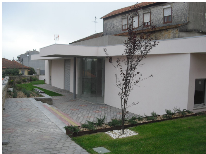
Figura 14 - Execução de arranjos exteriores em área envolvente do Corpo 2 (cedida pela empresa)
