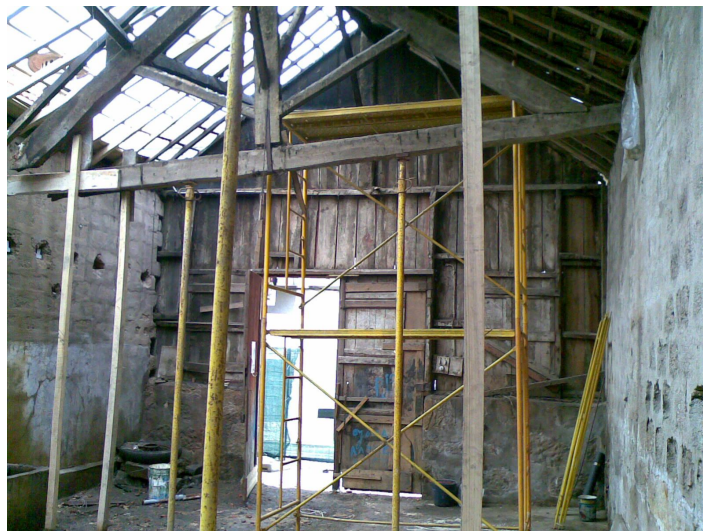
Figura 2 - Interior do edifício anterior ao início da empreitada (cedida pela empresa)
